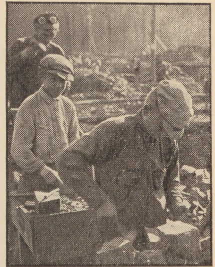
Ciosanie kostki bazaltowej.
