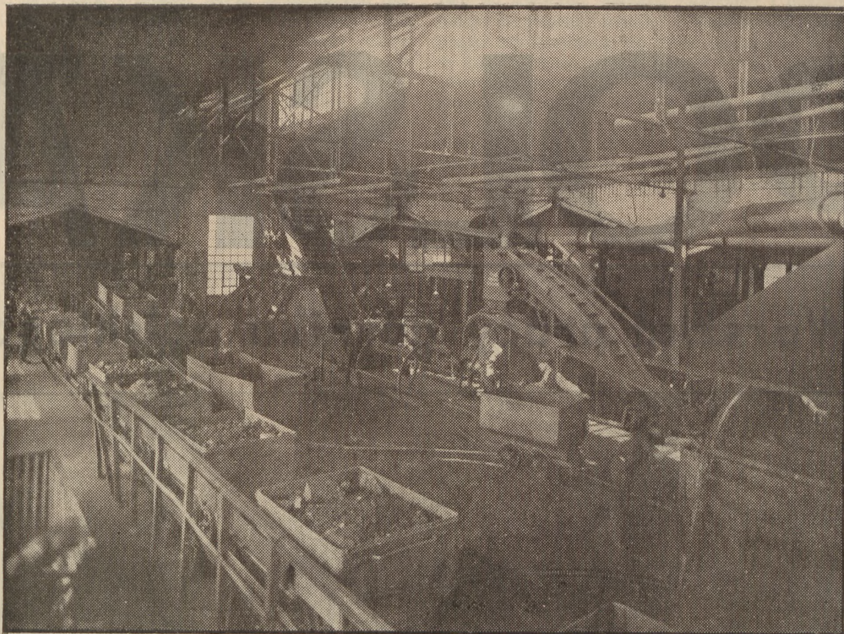
Pomost wywrotowy w sortowni kop. Siemianowice.
