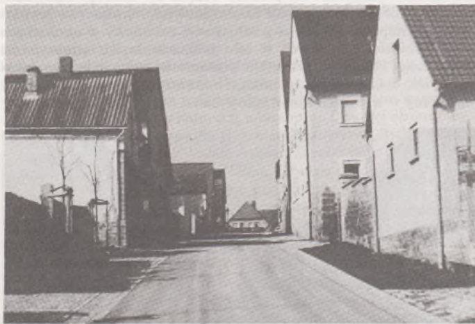
Fot. 10. Ulica wiejska po zakończeniu przebudowy: nawierzchnia asfaltowa, na brzegach rynny z kostki wapiennej, na pobocząch urządzone małe tereny zielone
