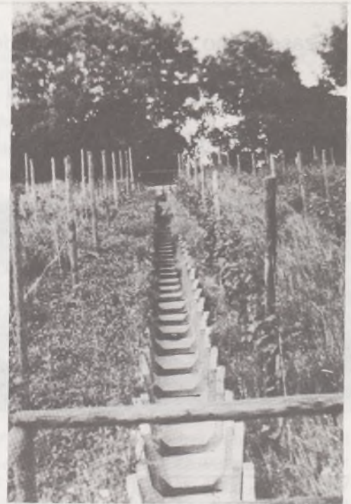
Fot. 5. Kanalizacja burzowa w winnicy: rynna odprowadzająca wodę na niższe poziomy
