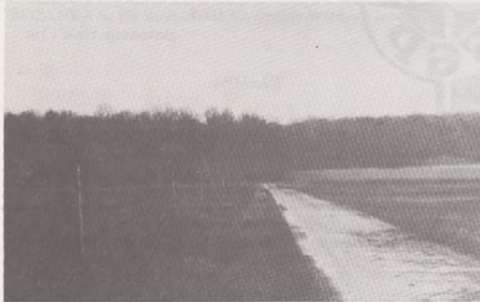
Fot. 3. Asfaltowa droga transportu rolnego: szerokość asfaltu 3,0 m. Po stronie południowej drogi zadarniony pas zadrzewień śródpolnych szerokości 5,0 m, obsadzony pojedynczym rzędem jabłoni
