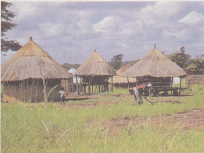
Fot. 6. Typowe budownictwo w Zimbabwe na terenach wsi. Czerwona gleba zmieszana ze słomą lub trzcinią stanowi tradycyjny materiał budowlany
