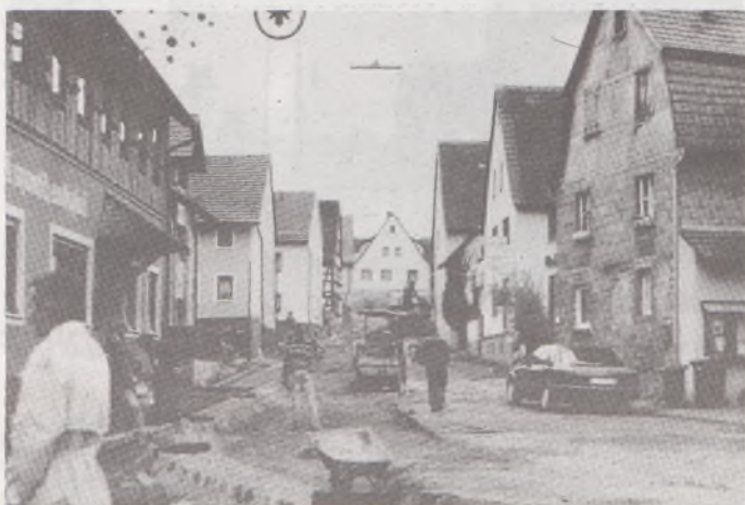
Fot. 9. Ulica wiejska w trakcie odnowy
