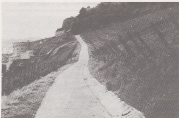
Fot. 4. Droga transportu rolnego w winnicy: nawierzchnia cementowa z rynną zamiast rowu, zapewniającą odprowadzenie wód
