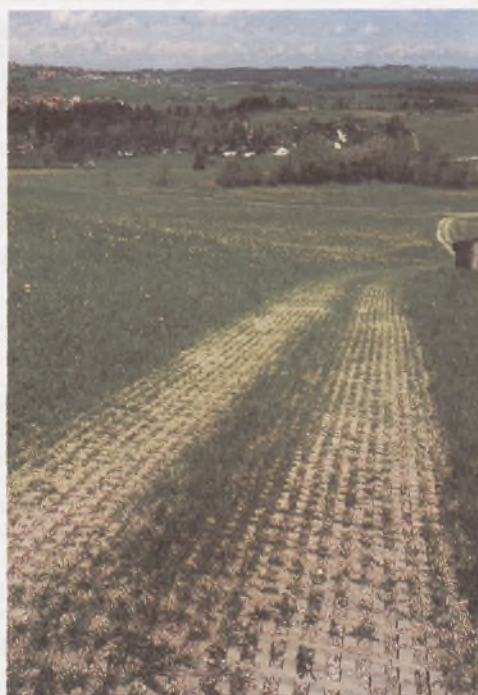
Fot. 10. Fragment drogi ekologicznej zbudowanej z specjalnych materiałów zapobiegających erozji i umożliwiających poruszanie się po niej w warunkach zimowych. Droga biegnie na wysokości ponad 1000 m nad poziomem morza i charakteryzuje się znacznymi spadkami
