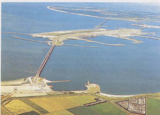
Fot. 9. Fragmenty zbudowanej sieci zapór oddzielających depresję Zeeland od Morza Północnego
