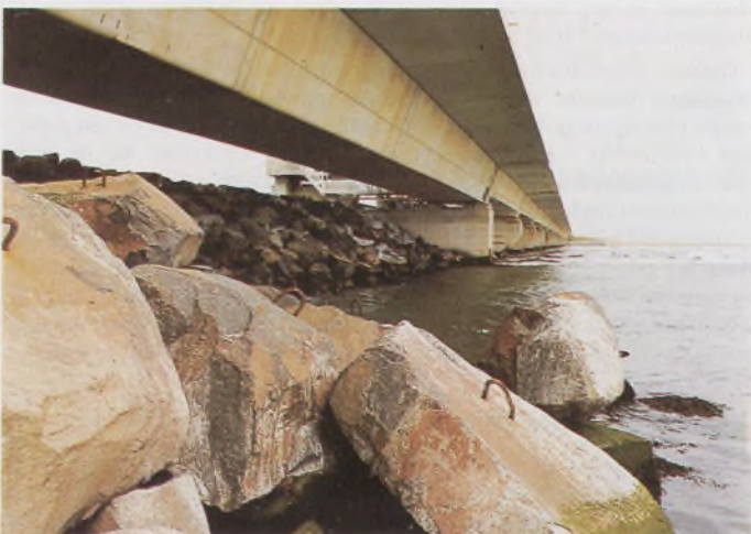
Fot. 10. Ogromne głazy granitowe użyte do budowy zapór. Głazy te przywożono statkami z Finlandii, bo w Holandii brak było tego typu materiałów budowlanych
