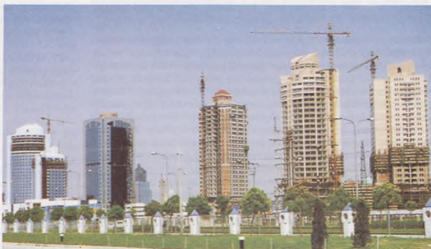
Fot. 6. Nowoczesne centrum biznesu i handlu Szanghaju w budowie
