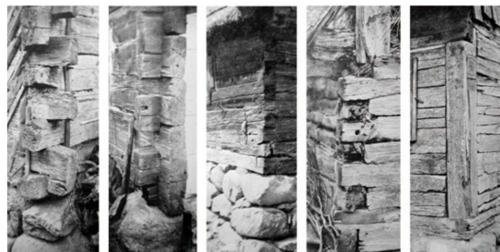
◀ Kamienne podwaliny pod konstrukcję zrębową (rybi ogon), mieszaną lub sumikowo-łatkową. Reprodukacja za: Bronisch, Ohle, Teichmüller, Kreis Bütow . Zbiory MPiMK-P, fot. autor.
