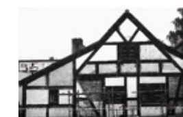
▲ Jedna z ostatnich chat zbudowana z belek okrętowych. Hel, 2008 r. Fot. M. Kuklik.
