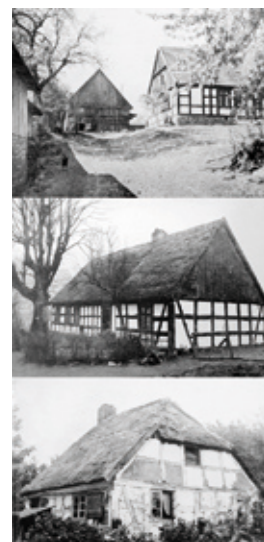
▲ Przykłady domów kaszubskich o konstrukcji szachulcowej: Szturzewo, Trzebiatówka, Jutrzenka. Reprodukacja za: Bronisch, Ohle, Teichmüller, Kreis Bütow.
