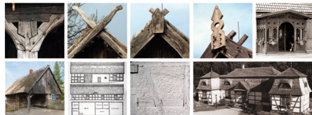
► Prostota i oszczędność materiału. Konstrukcyjność i funkcjonalność oraz praktyczność to nadrzędne cechy kaszubskiej architektury. Wykorzystanie łatwo dostępnych materiałów i praktyczność rozwiązań (ganki).
