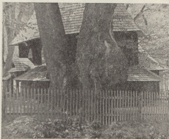
Ryc. 1. Sieniawa, stara wypróchniała lipa o obwodzie 7,90 m po zabezpieczeniu zastrzykami cementu
