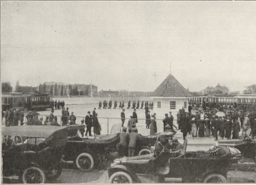
PROFNING AF VIADUKTENS BÄRKRAFT.
