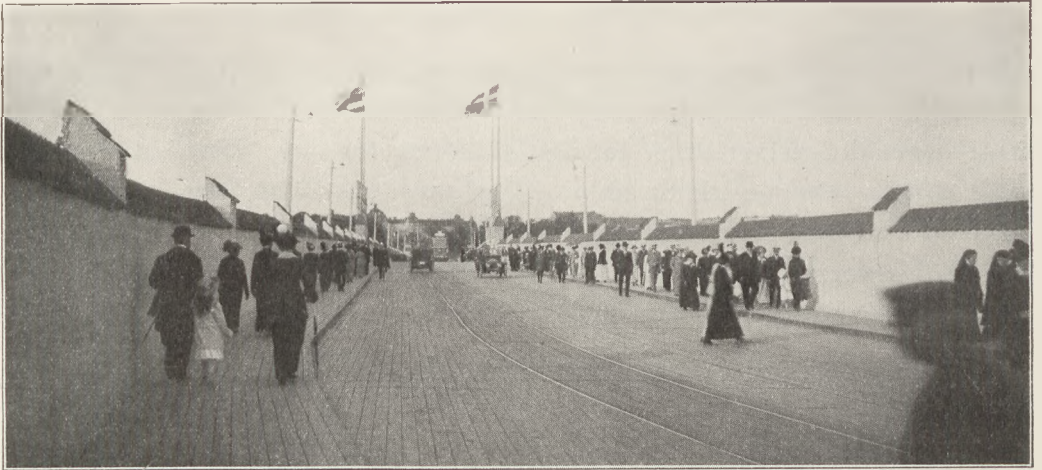
VIADUKTEN TILL UTSTÄLLNINGSSOMRÅDET.
