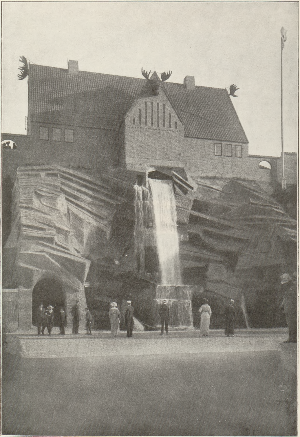
JAKTVILLAN. "BERGET" MED VATTENFALL.
