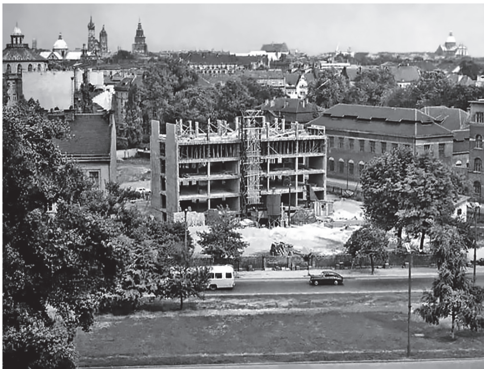
Il. 40. Nowy budynek Collegium Paderevianum w budowie (1962). Źródło: autor nieznan 212
