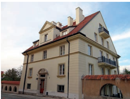
Ilustracja 214. Budynek na ul. Brzozowej 10, stan obecny (2019)
