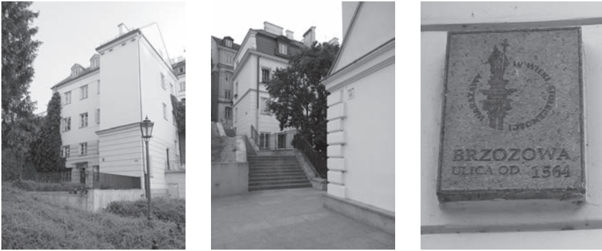
Ilustracja 215–217. Kamienica na ul. Brzozowej 12, stan obecny
