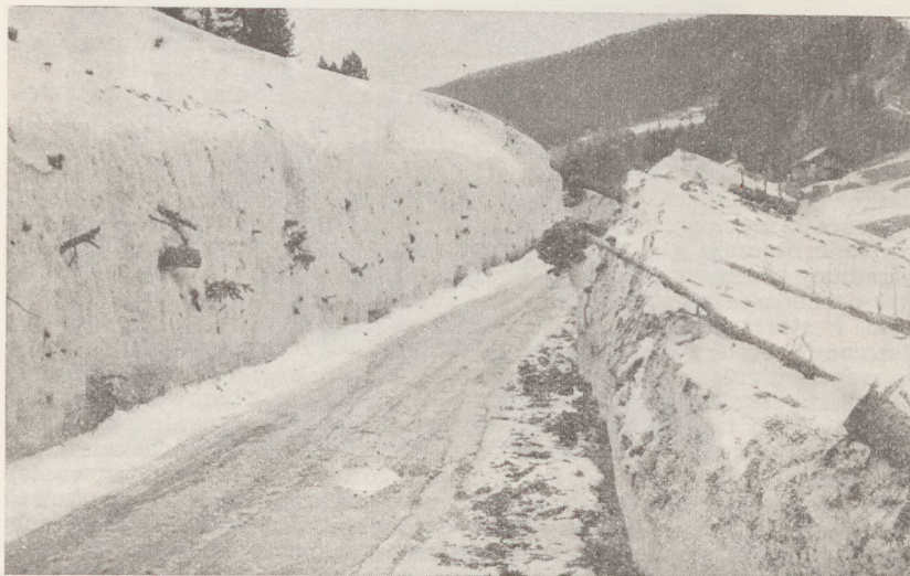
Ryc. 1. Wysokogórska droga z Kühtal do Ötz zasypana przez wtórną, śródleśną lawinę w marcu 1962 r. Wysokość przekopu około 6 m. Widoczne liczne pnie obalonych i porwanych przez lawinę drzew
