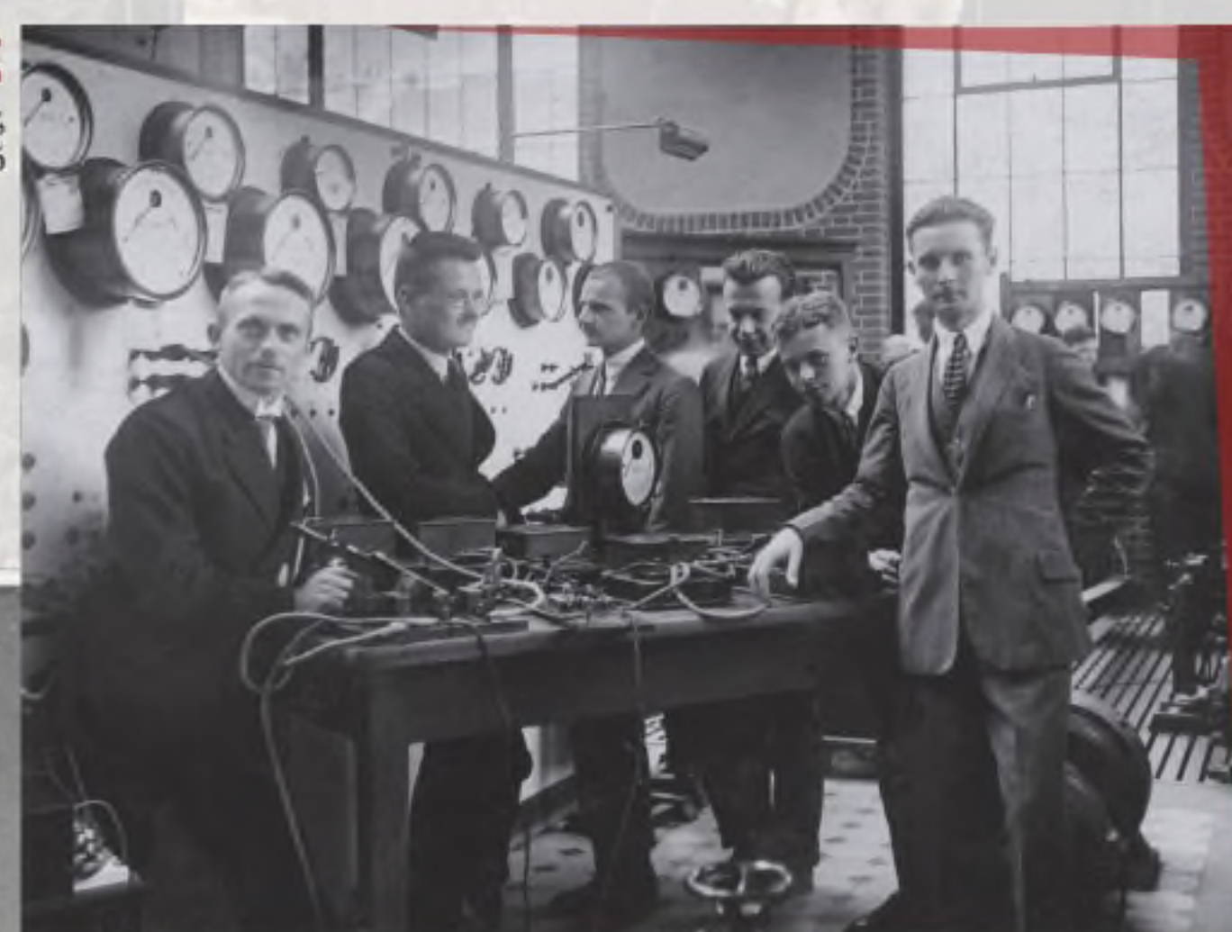
Fot. Studenci w laboratorium elektrycznym, 1926 Photo: Students in the electrical laboratory, 1926
