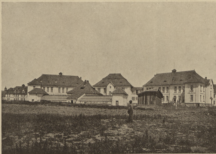
ZABUDOWANIA ZAKŁADOWE W KOBIERZYNIE
