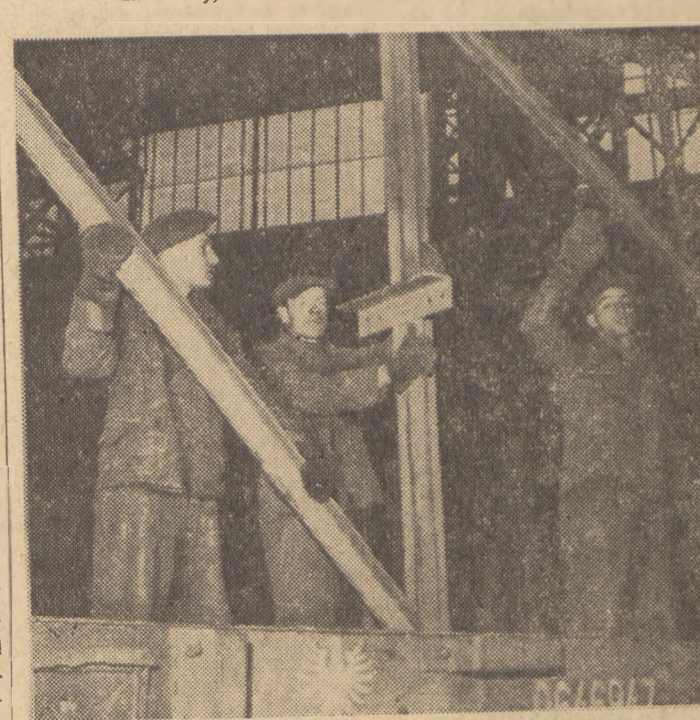
Setki wagonów, załadowanych konstrukcjami stalowymi, opuściły już hutę „Zabrze” z przeznaczeniem dla Nowej Huty. W grudniu ub. roku zalogi huty „Zabrze” ukończyły dostawę konstrukcji hali stalowej, wysyłając w tym jednym tylko miesiącu około tysiąca ton konstrukcji. Wiele z nich załadowała brygada transportowa Jana Bregaja, widoczna na zdjęciu. Zalogi „Zabrze” produkuje w dostawach dla Nowej Huty, wykonując je często przedterminowo
