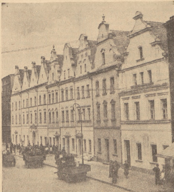
W Opolu prowadzone są poważne prace nad odbudową miasta i jego zabytkowej dzielnicy, Starego Rynku. Odbudowano już stronę południową, wschodnią, a w br. oddana będzie część północna. Na zdjęciu: fragment strony południowej. Foto A. Nowosielski
