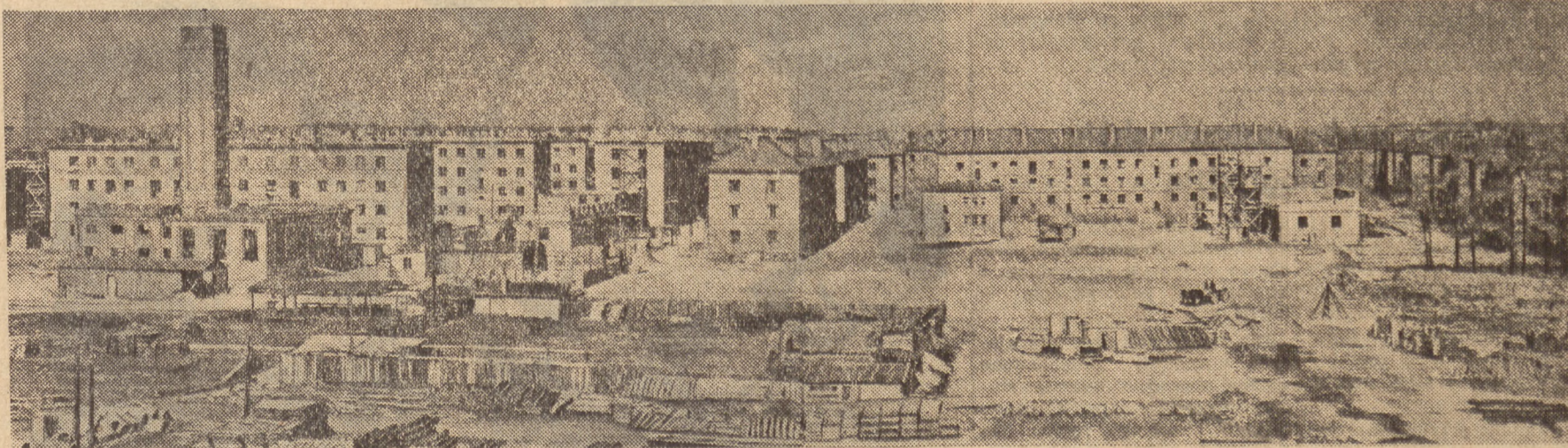
Trwają intensywne prace przy rozbudowie i budowie osiedla w Pyskowiec
