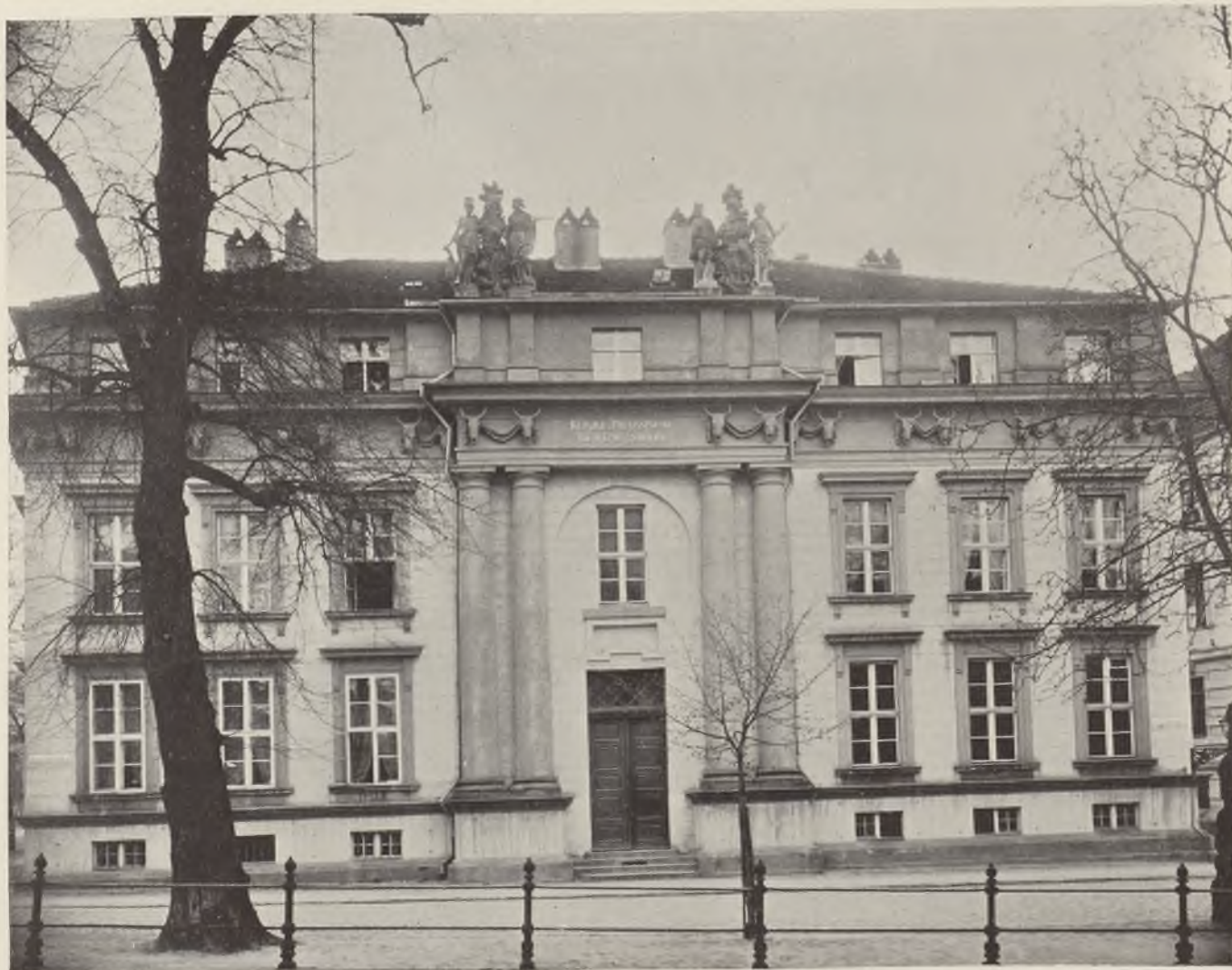
POTSDAM, KÖNIGLICHE GEWEHRFABRIK. ERBAUT 1755 NACH BÜRINGS PLAN FIGURENSCHMUCK VON BENKERT; DIE OCHSENSCHÄDEL VON KAMBLY
