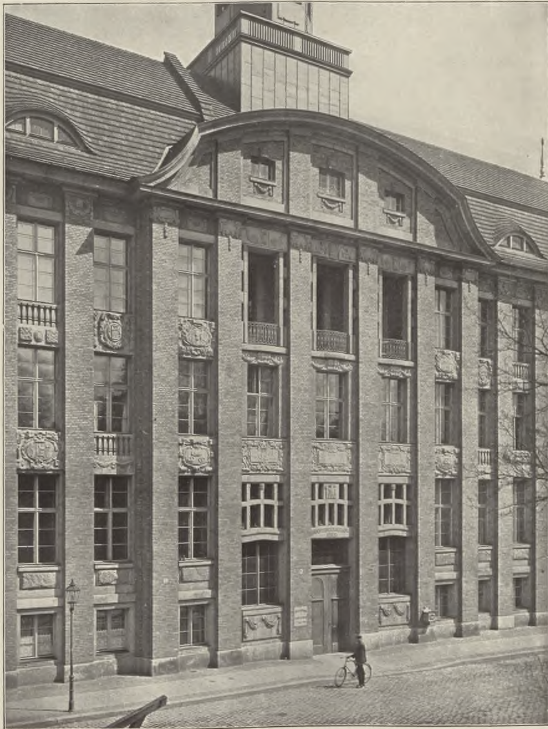
ALFRED MESSEL, GEBÄUDE DER LANDESVERSICHERUNGS-ANSTALT IN BERLIN
