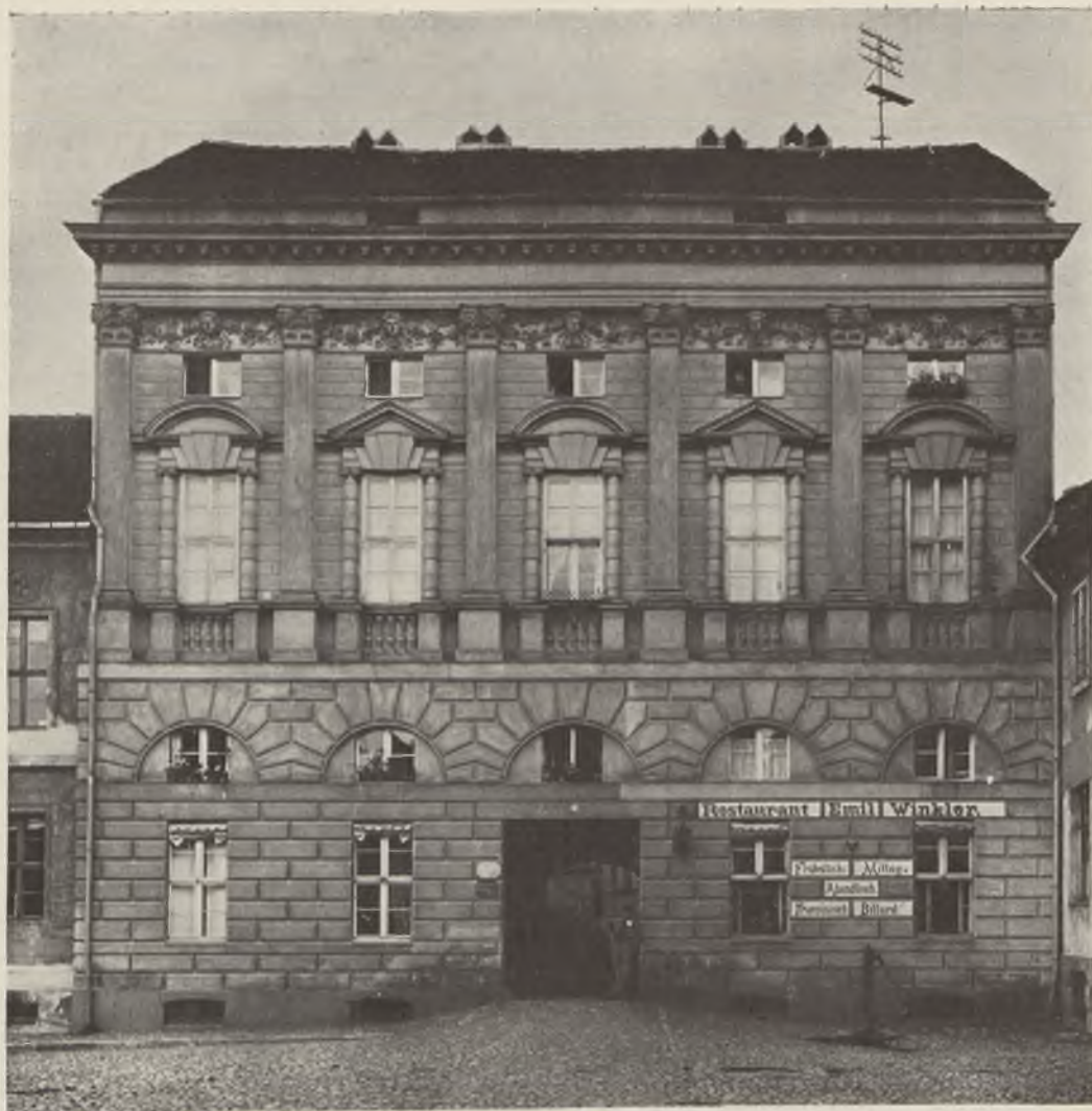
POTSDAM, AM NEUEN MARKT 5. ERBAUT 1755 KOPIE NACH FALLADIO, BILDHAUEREI VON EPPEN
