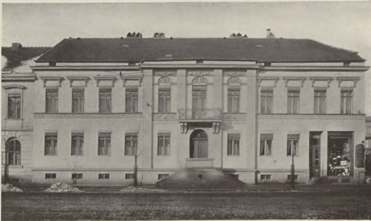
POTSDAM, BERLINERSTR. 1. ERBAUT AM ANFANG DES 19. JAHRHUNDERTS
