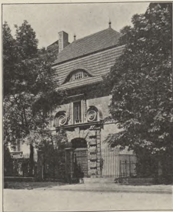
ALFRED MESSEL, STALLGEBÄUDE. BERLIN, VICTORIASTRASSE
