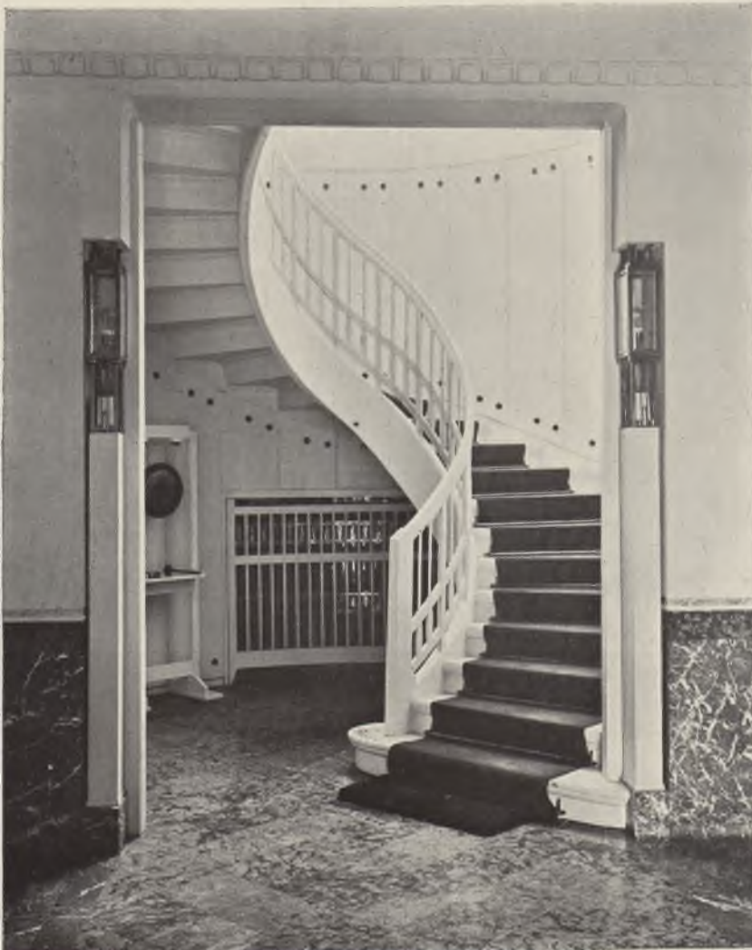
HENRY VAN DE VELDE, TREPPE IM HAUSE OSTHAUS IN HAGEN I. W.
