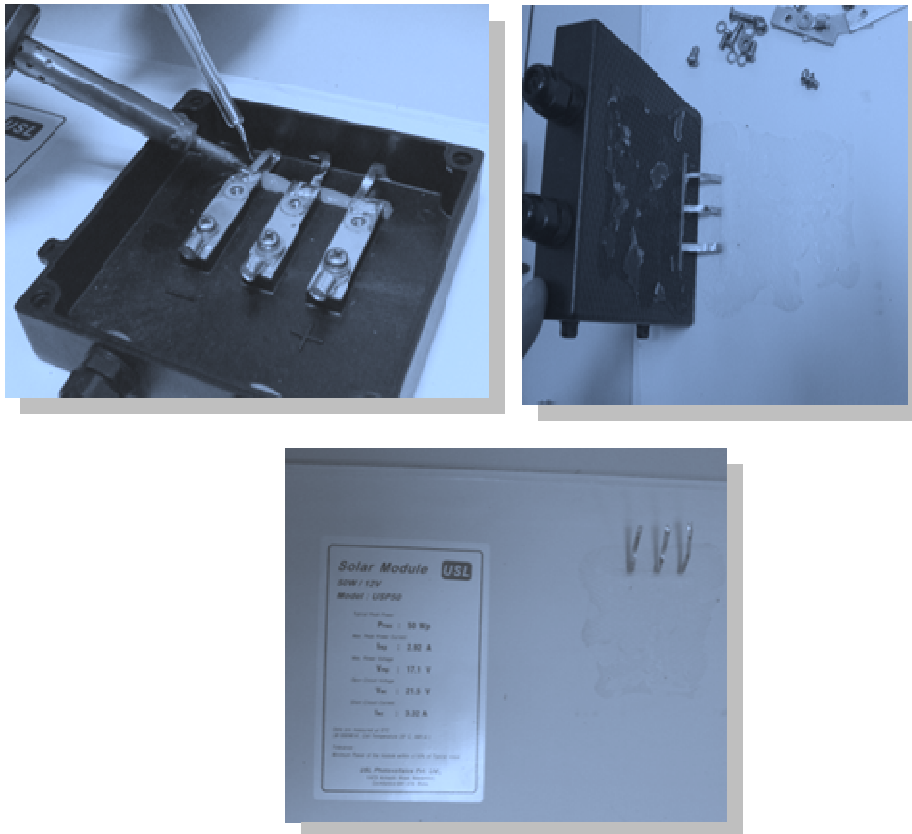
Rys. 5. 17. Demontaż puszki przyłączeniowej zużytego modułu PV [ 39 ]
