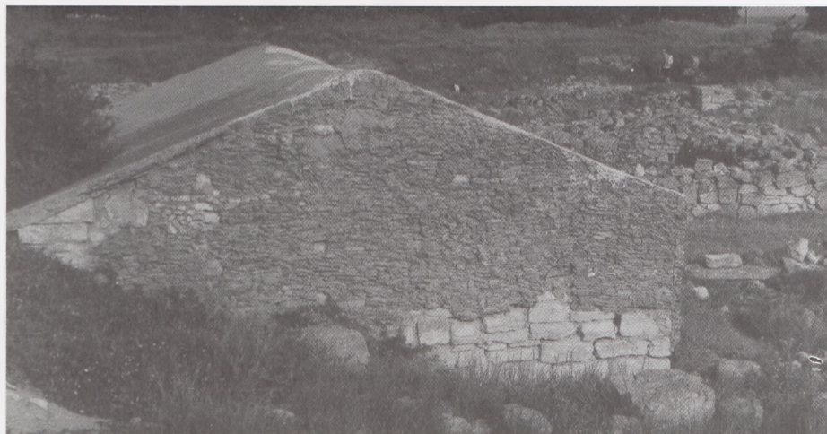
Współczesny budynek osłaniający starożytne pozostałości
