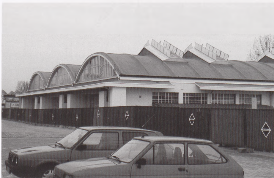
Nowy gdyński obiekt wkrótce uwolni się od ochrony i budowlanego parkanu
