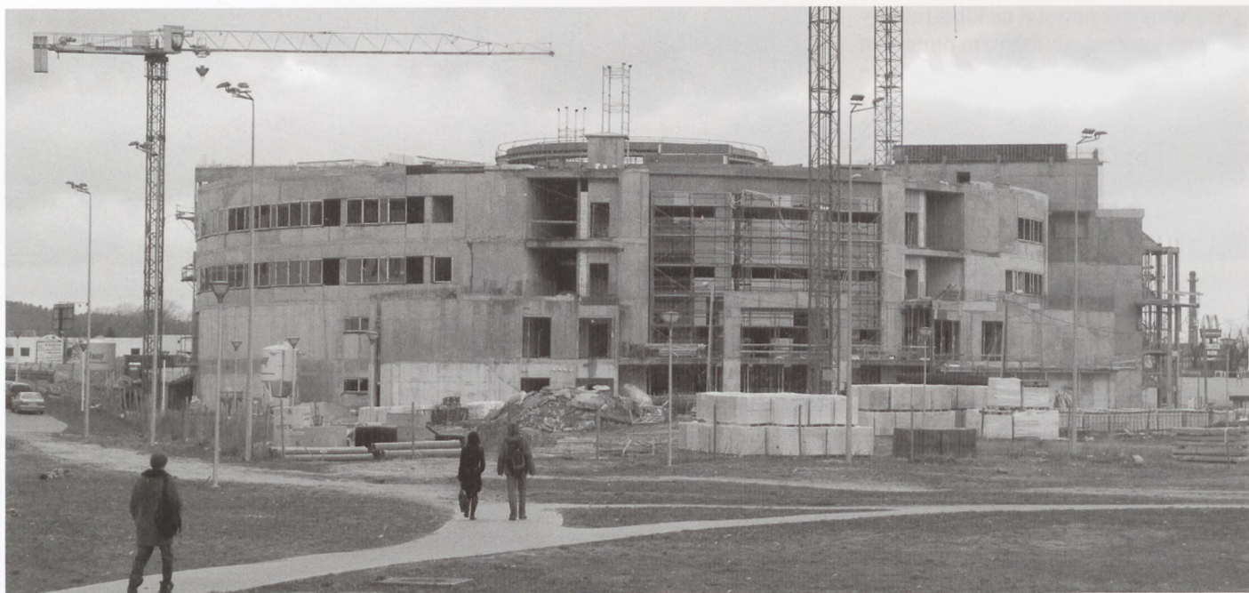
Budowa nowego gmachu Wydziału Nauk Społecznych
