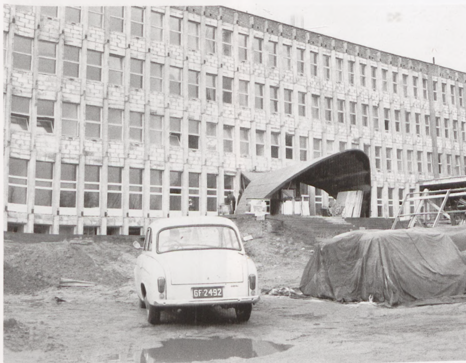
Budowa gmachu Wydziału Ekonomii Transportu UG przy Armii Czerwonej, a obecnie Armii Krajowej w Sopocie (październik 1970 roku)
