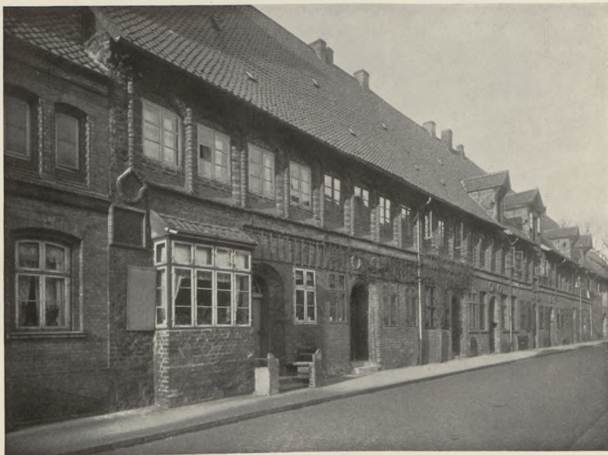
LÜNEBURG. WOHNUNGEN FÜR STÄDTISCHE BEAMTE (REITENDE DIENERSTRASSE).
