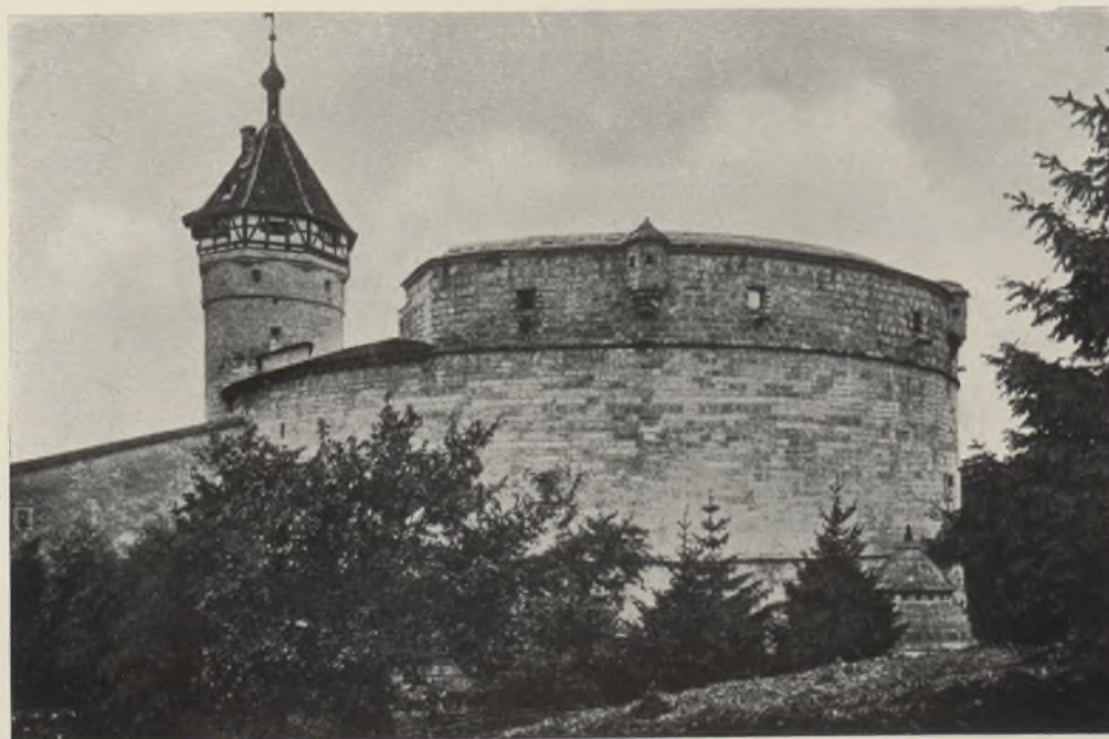
SCHAFFHAUSEN, MUNOT. BEFESTIGUNG FÜR FEUERGESCHÜTZ, 1564—1585 ERBAUT
