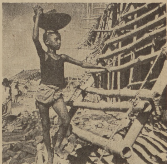
Milliony młodocianych w Indiach, a nawet dzieci są zatrudniane przez kapitalistów przy ciężkich robotach. Na zdjęciu: chłopak zatrudniony przy budowie.
