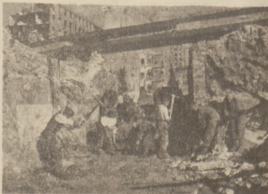
Bataliony SP pracują przy poszerzaniu ul. Marszałkowskiej w Warszawie. (Październik 1948 r.).
