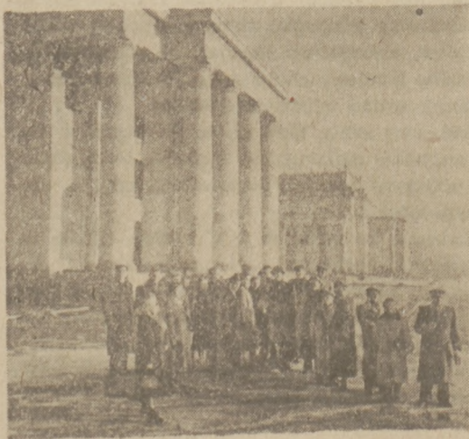
W trzecim dniu obrad uczestnicy Zjazdu zwiedzili Pałac Kultury i Nauki w Warszawie. Na zdjęciu: inżynierowie radzieccy oprowadzają młodzież po terenie budowy.
