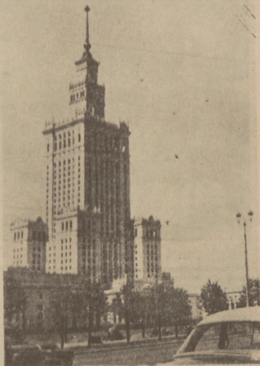
Pałac Kultury i Nauki im. J. Stalina. Część wysokociowa, widziana od strony ul. Marszałkowskiej.
