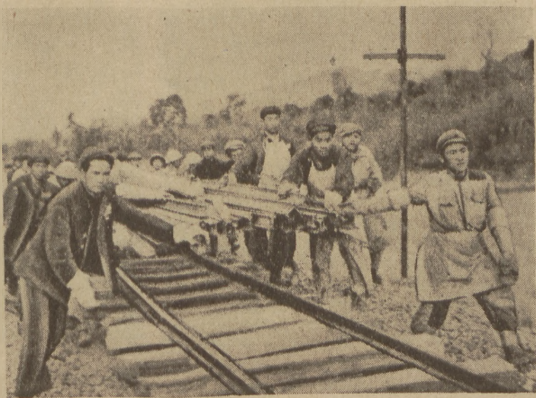
Na budowie linii kolejowej Hanoi — Nam-Quan (obec- nie już oddanej do użytku)
