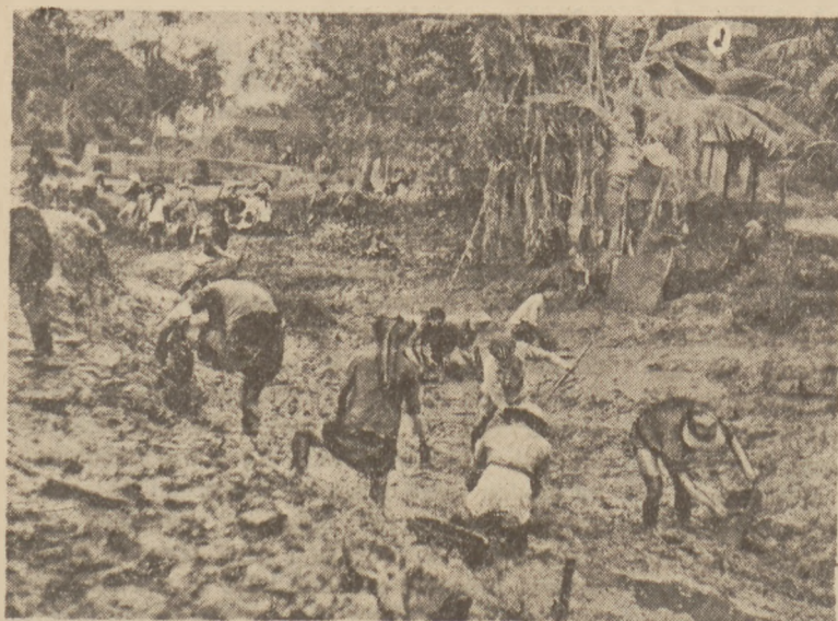
Cala ludność bierze udział przy odbudowie kanałów nawadniających zniszczonych przez okupantów.
