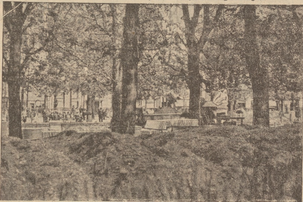
W Ogrodzie Luksemburskim w Paryżu przeprowadzane są prace nad budową ziemnych schronów gazowych.
