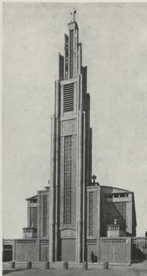
BRACIA PERRET: KOŚCIÓŁ W RAINCY (FRANCJA), zbudowany w r. 1923.
