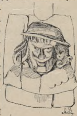
ZAMEK W PODHORCACH. Konsola stropowa. (Rys. A. Szyszko-Bohusz).
