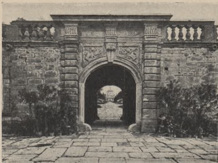
ZAMEK W PODHORCACH. Brama wjazdowa od strony podwórca.
