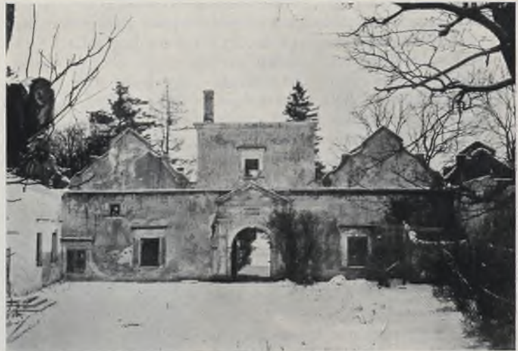
Ryc. 246. Świrz. Zamek po zniszczeniu wojennym.
