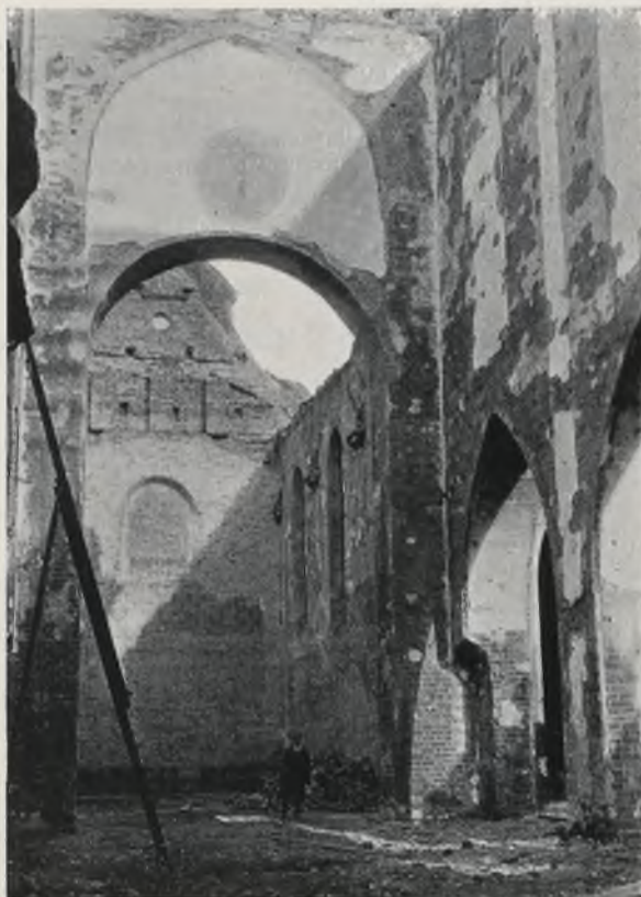
Ryc. 271. Brześć Kujawski. Kościół podominikański. Wnętrze po pożarze w 1922 r.
