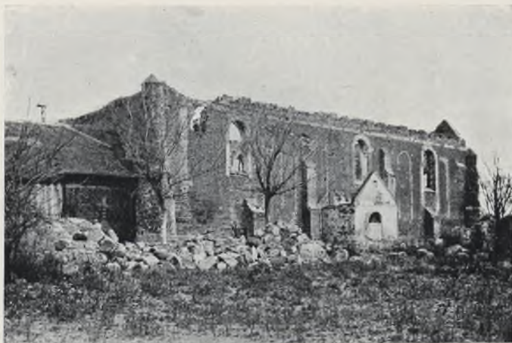
Ryc. 252. Pawłowo. Kościół parafjalny po zniszczeniu wojennym.
