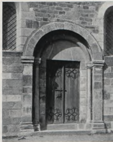
Ryc. 290. Kruszwica. Kolegiata. Portal boczny.
