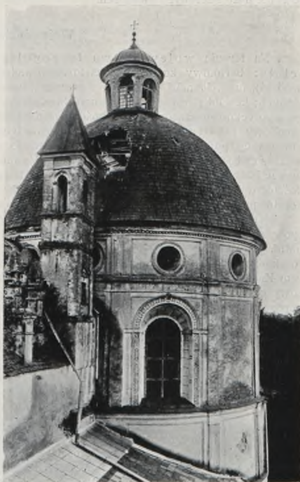
Ryc. 241. Krasieczyn. Zamek. Kaplica po zniszczeniu wojennem.
