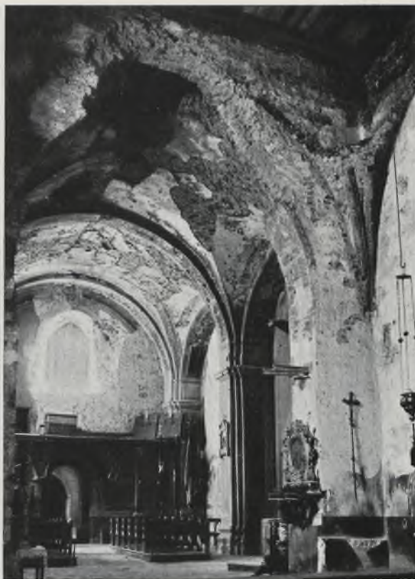
Ryc. 236. Felsztyn. Kościół parafialny. Wnętrze po zniszczeniu wojennym.
