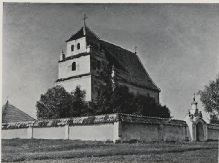
Ryc. 268. Ostaszyn. Kościół (d. zbór kalwiński) doszczętnie zniszczony w czasie wojny.
