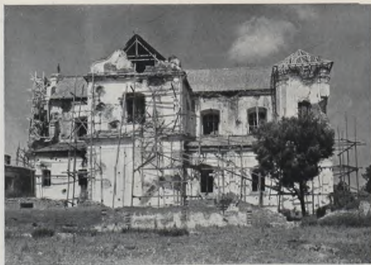
Ryc. 267. Lubieszów. Kościół popijarski w trakcie odbudowy po zniszczeniu wojennym.
