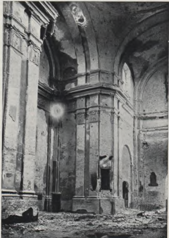
Ryc. 239. Sieniawa. Kościół paraf. po zniszczeniu.
