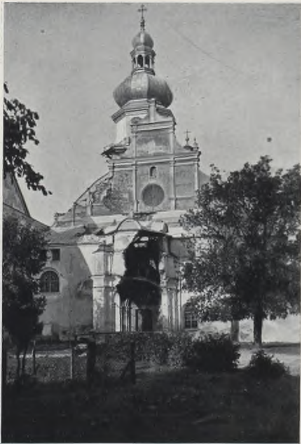
Ryc. 238 Sokal. Kościół OO. Bernardynów po zniszczeniu wojennym.
