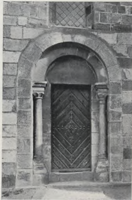
Ryc. 291. Kruszwica. Kolegiata Portal boczny.
