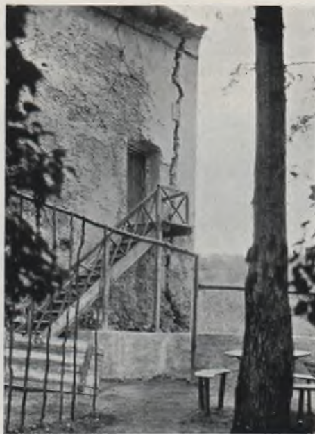
Ryc. 283. Pieskowa Skala. Zamek Naroznik zagrożonej partji muru.
