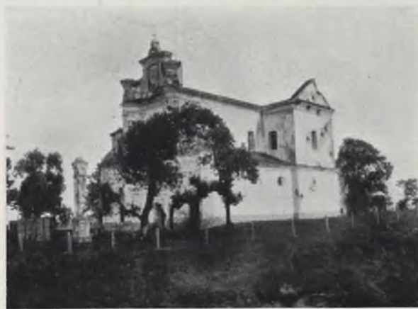
Ryc. 263. Czartorysk. Kościół parafjalny po zniszczeniu wojennym.
