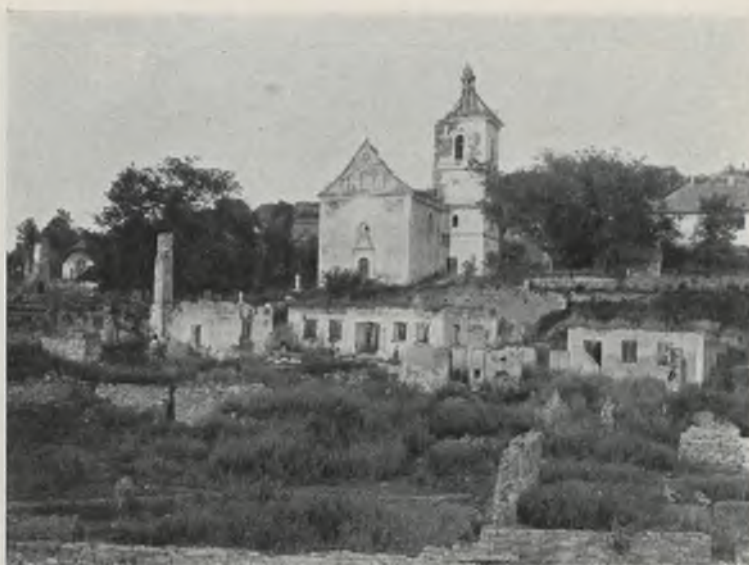
Ryc. 243. Jazłowiec. Cerkiew (d. katedra ormiańska) po zniszczeniu wojennym.
