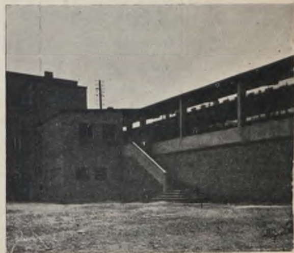
Na prawo: widok na podjazd główny. Na lewo: wyjście z peron
