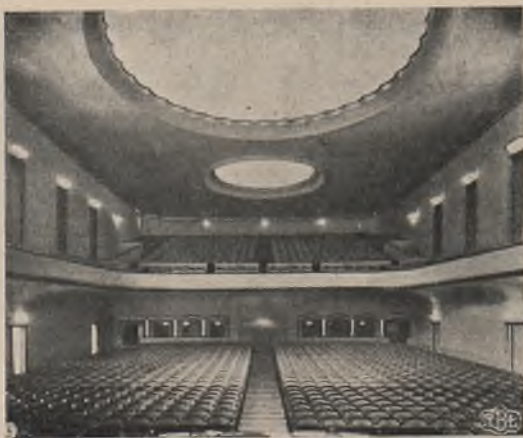
7. Widownia teatru Apollo w Zurichu. Reflektory ukryte za gzymsem.
