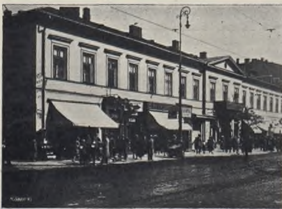
5. Dom na rogu ulic Złotej i Marszałkowskiej. Dlaczego ustawa o ochronie lokatorów paraliżuje ruch budowlany w śródmieściu? Oto przykład: w tym miejscu stać miał reprezentacyjny gmach T-wa. Ubezpiecz. „Generali”. Budowa nie doszła do skutku, gdyż „odszkodowania”, których żądali lokatorzy, dochodziły do miliona złotych.
