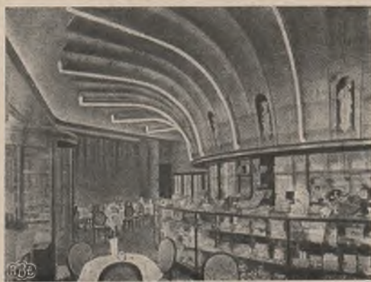
25. Oświetlenie kawiarni rurkami Moor'a.
