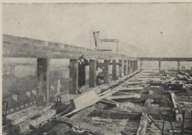
18-19. Konstrukcja wieńcowa, wykonana cementem szybkotwardniejącym w gmachu Min. Robót Publ. w Warszawie przy - 10 o C. Projekt arch. Rudolfa Świerczyńskiego (Warszawa).
