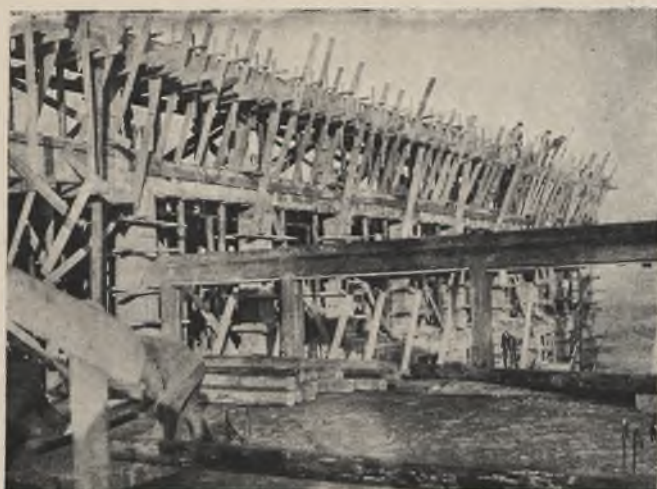
18-19. Konstrukcja wieńcowa, wykonana cementem szybkotwardniejącym w gmachu Min. Robót Publ. w Warszawie przy - 10 o C. Projekt arch. Rudolfa Świerczyńskiego (Warszawa).
