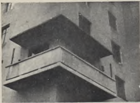
13—14. Próba ukształtowania balkonu (funkcjonalny), chronionego przed deszczem („wydobycie narożnika“). Dom przy zaulku Leśnoriadskim w Moskwie.
