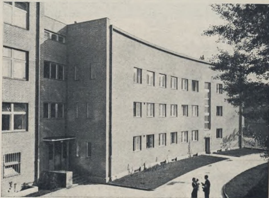
Skrzydło mieszkaniowe. Widok od dziedzińca.
