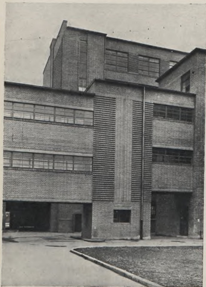
Elewacja galerji, łączącej magazyn ze starą częścią Wytwórni.
