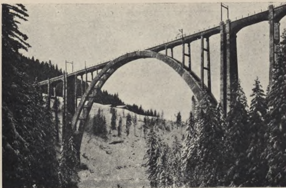
Rys. 3. Dyr. Kolei Chur-Arosa. Most kolejowy. (Szwajcaria).
