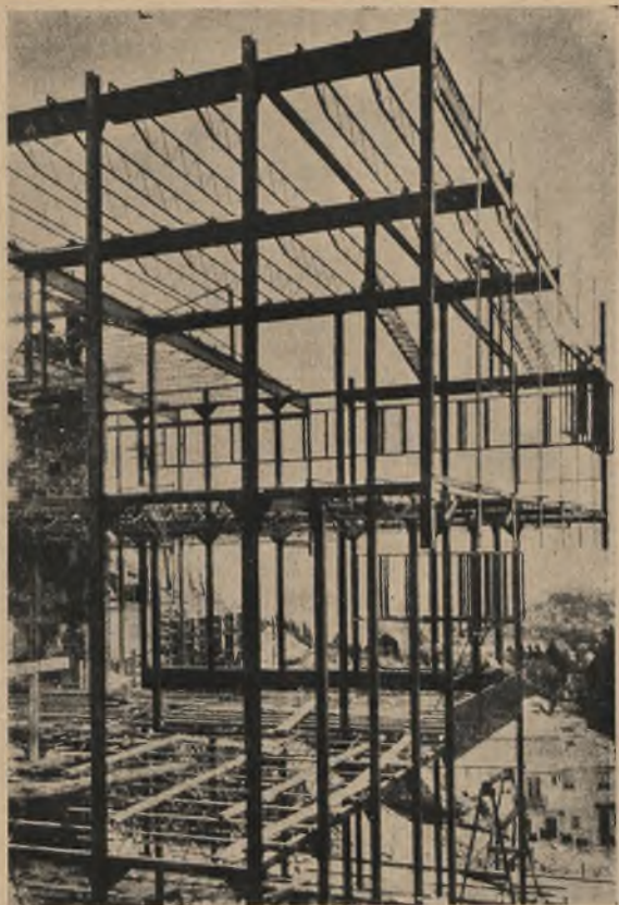
14—15. Konstrukcja żelazna, spa- wana elek- trycznie.
