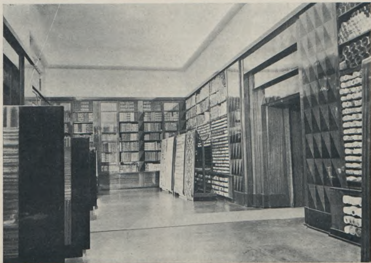
Arch. Stefan Sienicki (Warszawa). Wnętrze magazynu firmy Franaszek.
