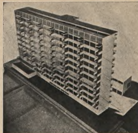
1. Arch. Walter Gropius. Projekt stalowego domu mieszkalnego z centralną salą do wspólnego użytku. System z galerijkami. 10 pięter. 60 mieszkań najmniejszych.
