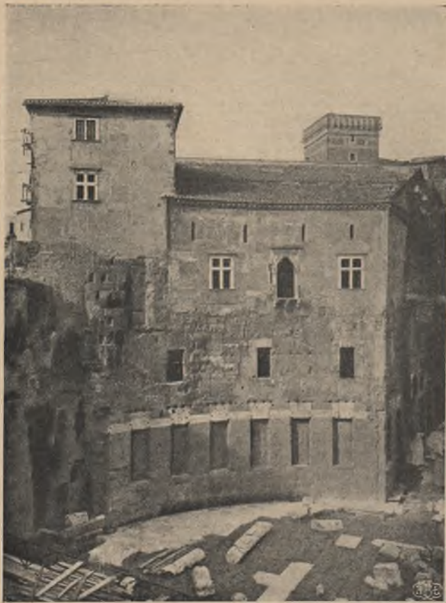
17. Klasztor Joannitów, zbudowany na resztkach północnego muru Forum Augusta.
