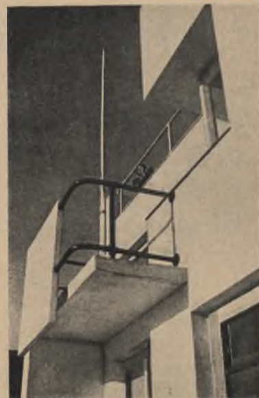
Balkon. Płyta wisząca betonowa na słupce. Barjera z rur garo- wych, polerowana i malowana lakierem przezroczystym.
