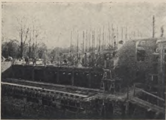
14. Układanie belek stropów składanych w budynku Gimn. im. J. Słowackiego w Warszawie. Projekt arch. T. Nowakowskiego (Warszawa).
