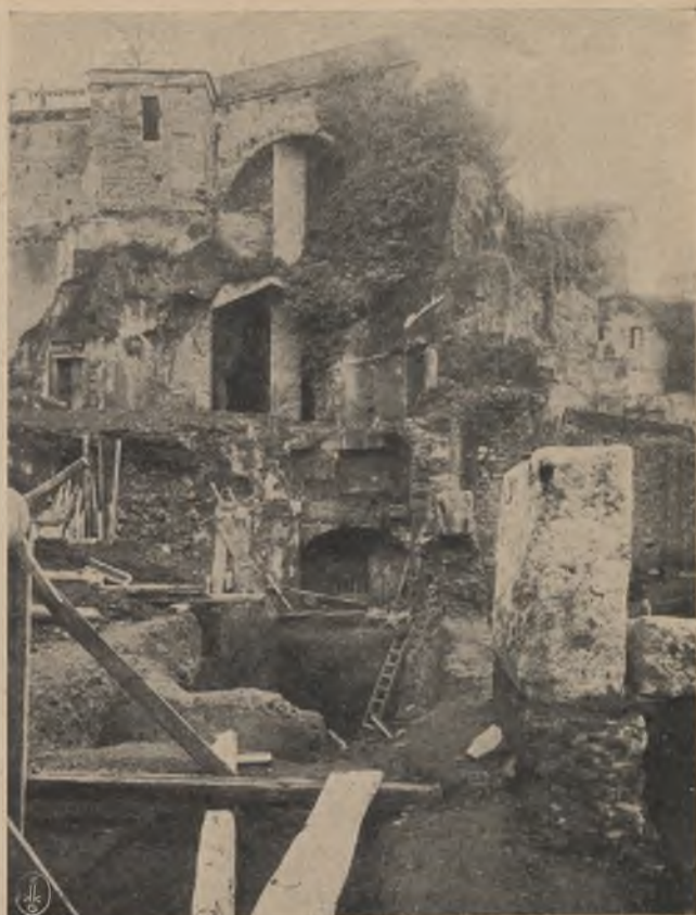
5. U podnóża Kapitolu. Skała Tarpejska w trakcie burzenia obudowujących ją budowli.
