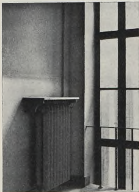
Szczegół klatki schodowej bursy
