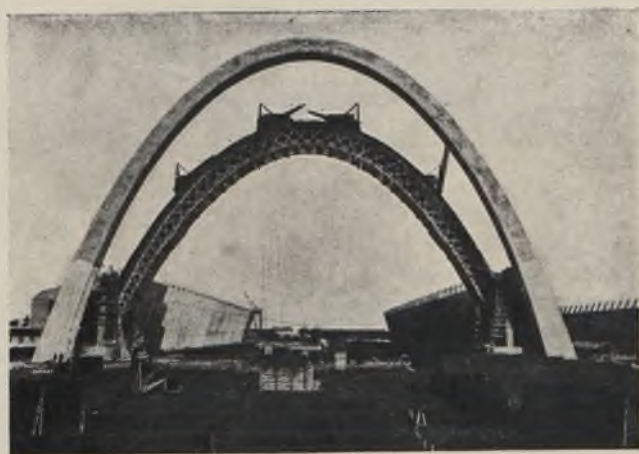
Rys. 14. Freyssinet. Hala sterowców (w czasie budowy). Orly-Paris (Francja).
