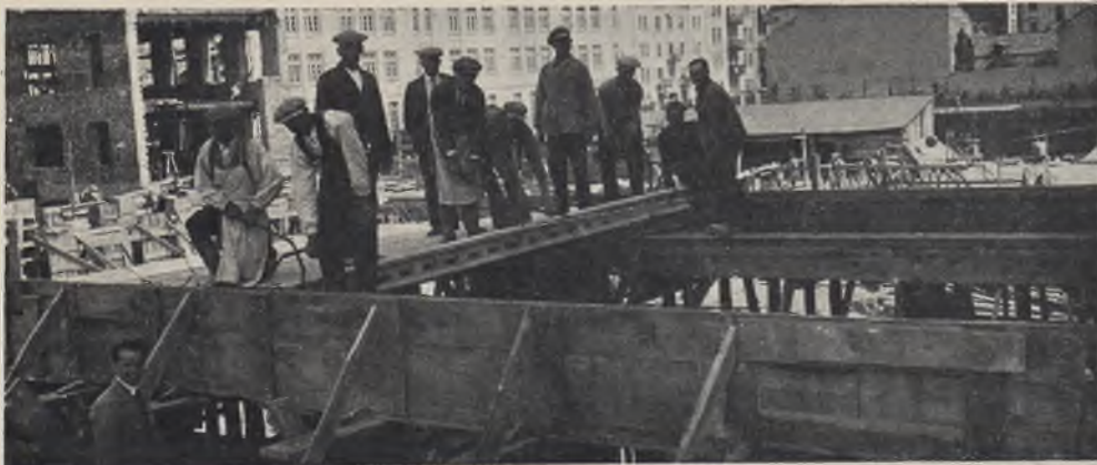
6. Ułożenie stropów składanych typu „Rapid” na budowie gmachu M. R. Publ. w Warszawie.
