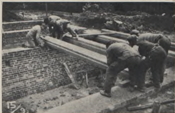
9. Układanie belek stropu składanego.
