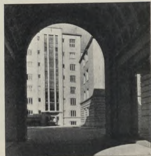
Widok na gmach biurowy z bramy hotelu i bursy.
