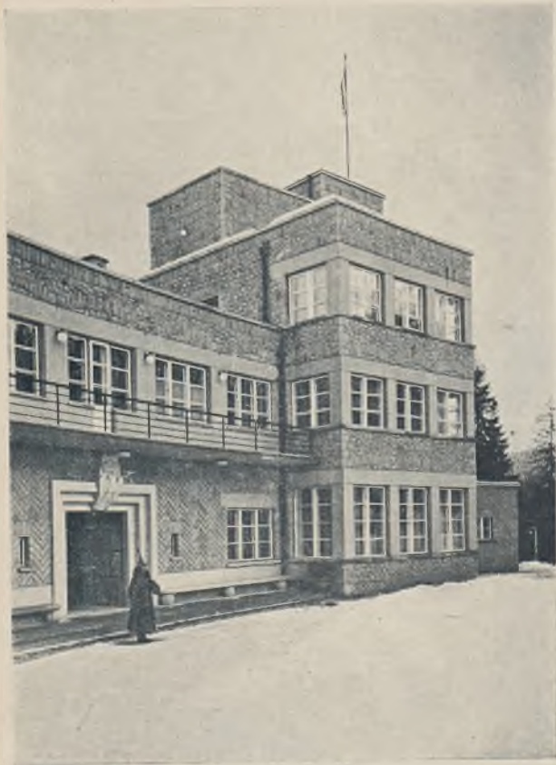
Fragment elewacji zachodniej.
