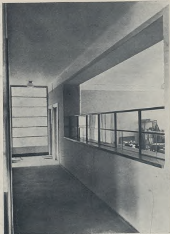
Fragment biur na I-em piętrze.
