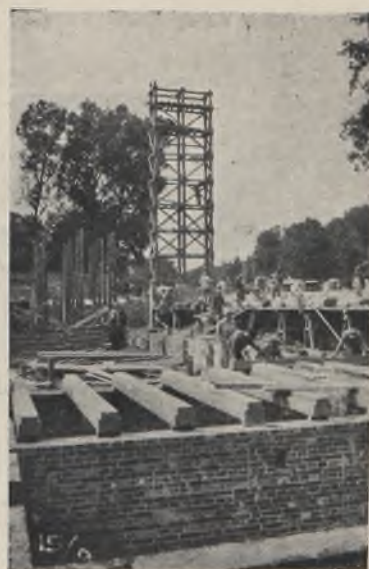
10. Ułożenie belek stropu składanego.
