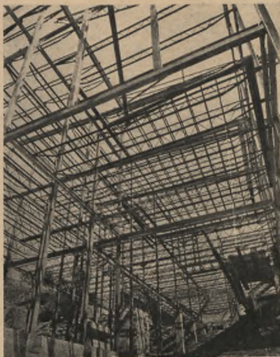
14—15. Konstrukcja żelazna, spa- wana elek- trycznie.
