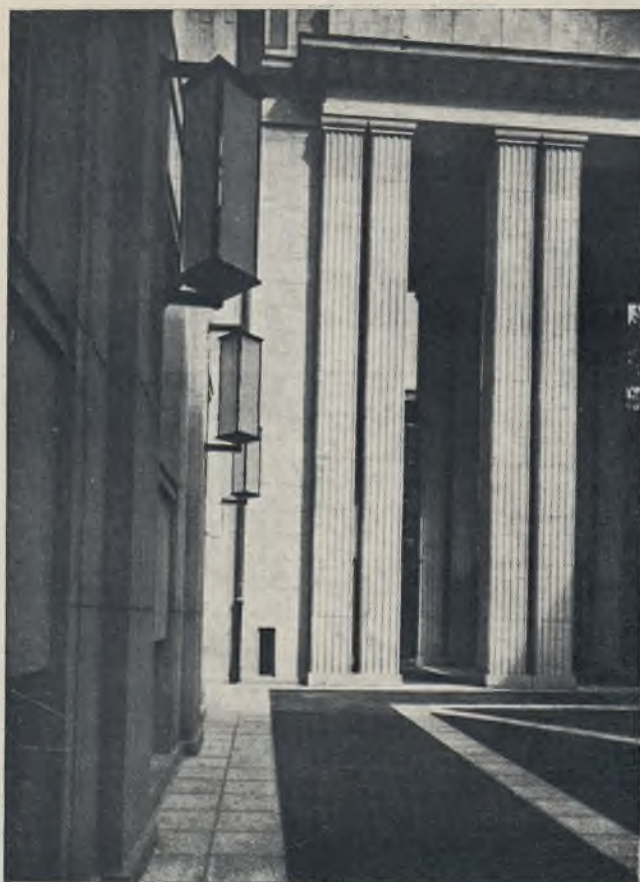
11 – 12. Arch. Zdzisław Mączyński (Warszawa). Gmach Ministerstwa W. R. i O. P. w Warszawie. Fragmenty podwórca głównego.
