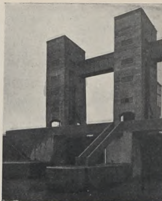
13. Paul Bonatz. Stuttgart. Śluza na kanale Nechar. Niemcy.
