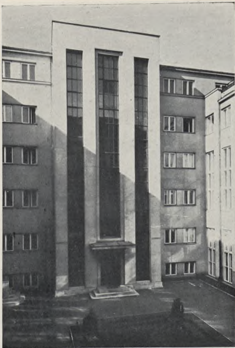
Klatka schodowa bursy.
