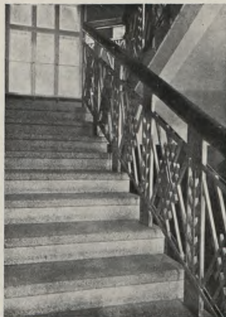
Szczegół bocznej klatki schodowej
