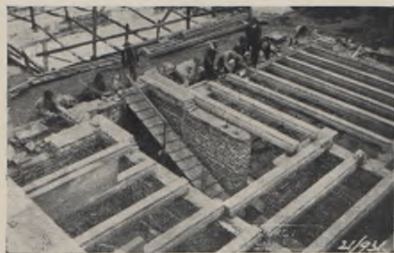
11. Układanie belek stropu składanego.
