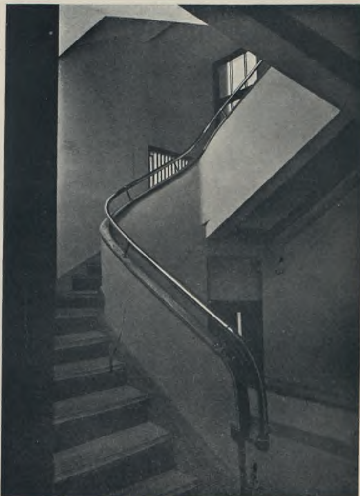
Klatka schodowa w skrzydle bocznym.
