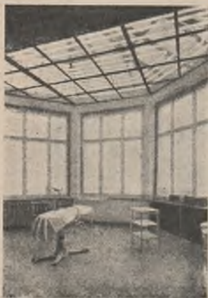
23. Oświetlenie sali operacyjnej rurkami Moor'a.
