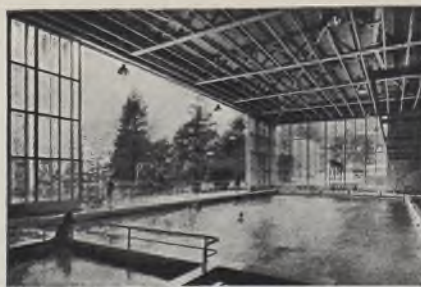
Arch. A. v. Liebe i L. Stigler. Pływalnia na Semmeringu. („Der Bau-meister“).
