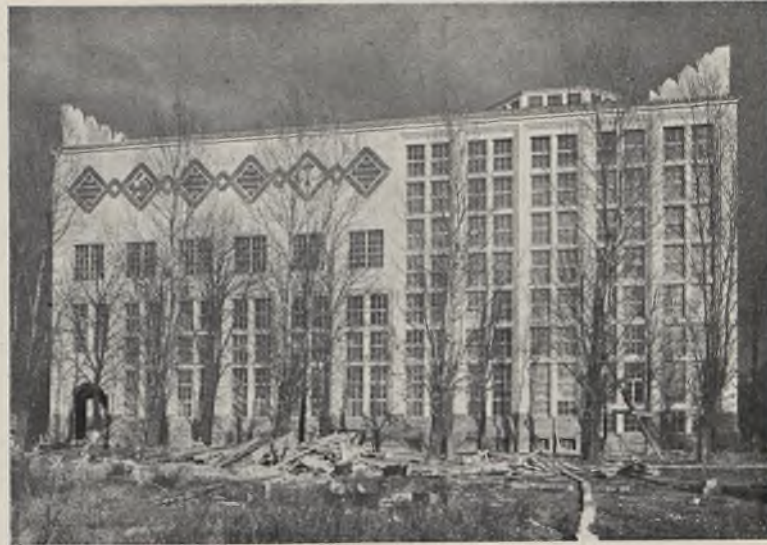
5—8. Arch. Jan Witkiewicz-Koszczyc (Warszawa). Gmach biblioteczny W. S. H. w Warszawie. Lice boczne. Dachy płaskie, izolowane „Aquisolem” i kryte „Bitumina”, wykonała f. „Orlorog” — Warszawa.
