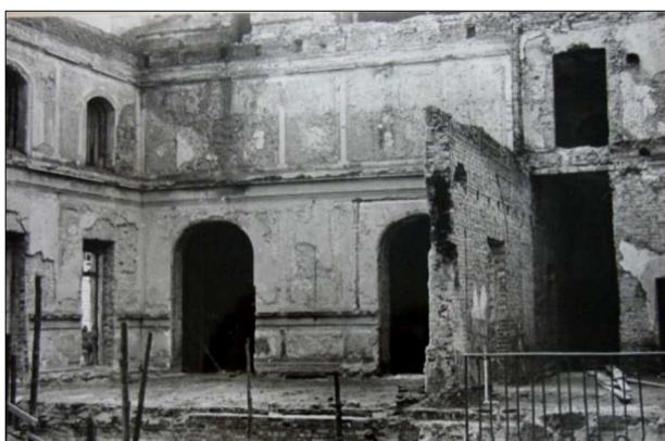
Fot. 36. Pałac Branickich – zniszczenia wojenne, 1944 r. (AUMB)
