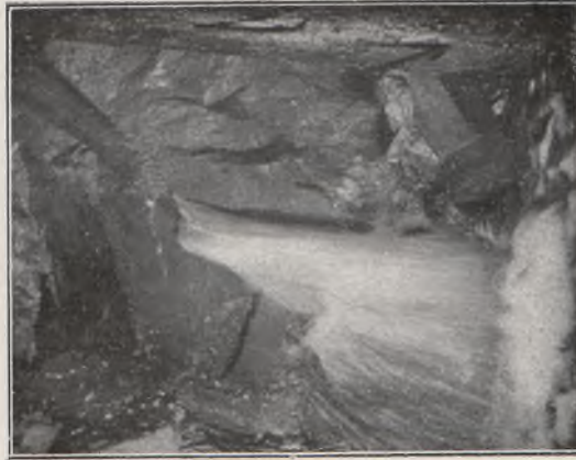
Fig. 7. Im Simplon-Tunnel, Galerie I. Quelle No. 40, den 4. März 1903 angeschlagen. N. H. Schardt.
