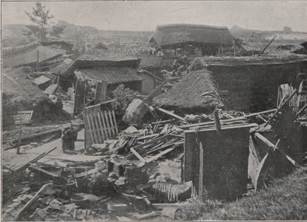
Erdbeben in Zentral-Japan, 1891 Oktober. Zerstörung der Gebäude.
