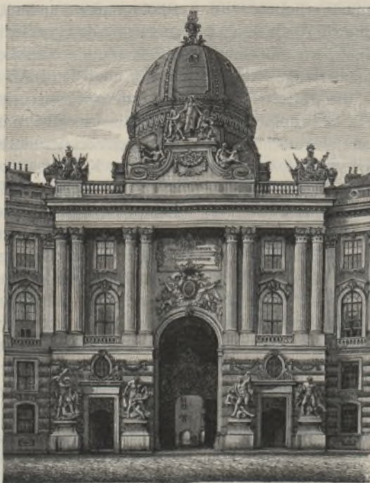
Abb. 1. Nordportal am Neubau der k. k. Hofburg.
