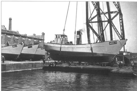
Wodowanie kutra "Arka 3", jednego z dziesięciu pierwszych stalowych kutrów (ze zbiorów Wydaw. "Okrętownictwo i Żegluga")
