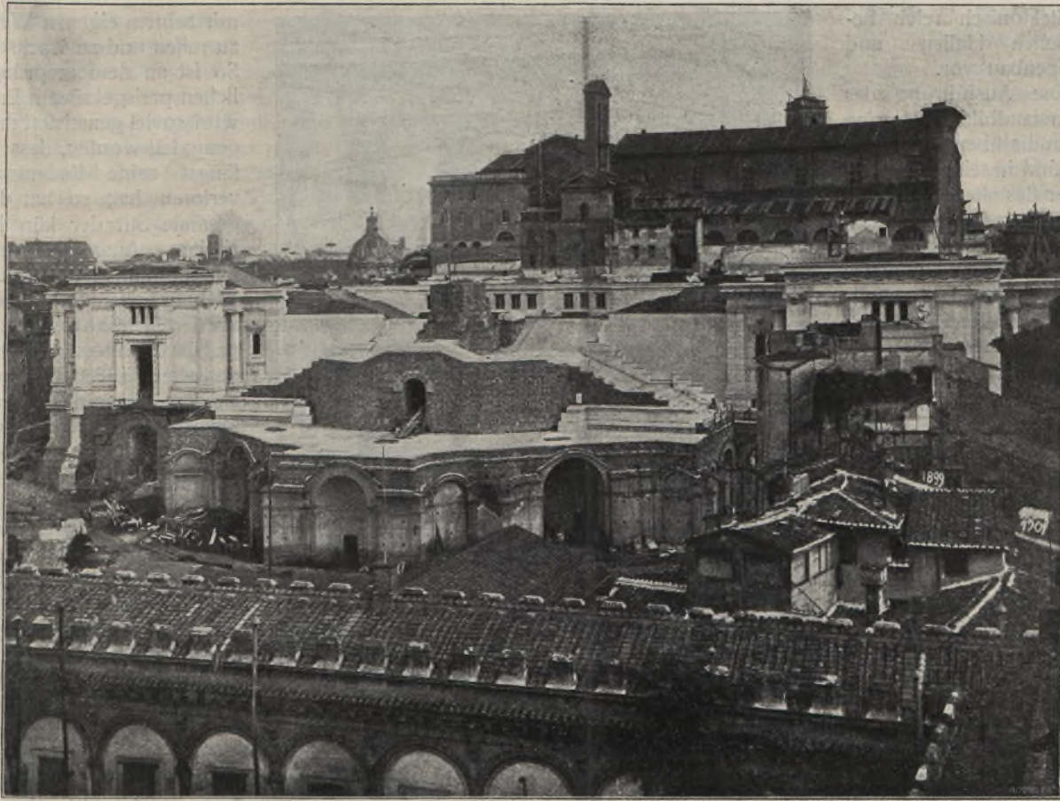
Gesamtansicht des Victor Emanuel-Denkmal in seinem jetzigen Bauzustande
