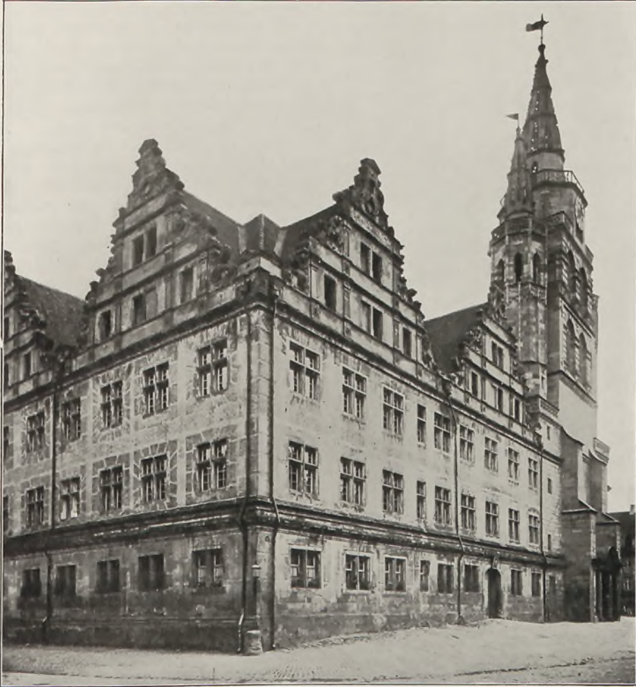
Abb. 299 Ehemaliges Gymnasium, jetzt Bezirksgericht, zu Ansbach
