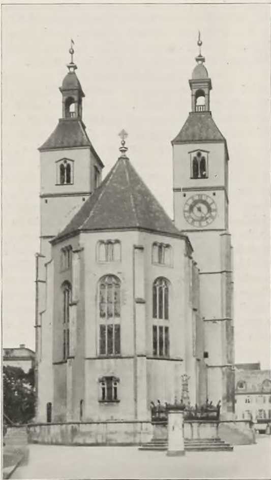
Abb. 205 Neupfarrkirche zu Regensburg
