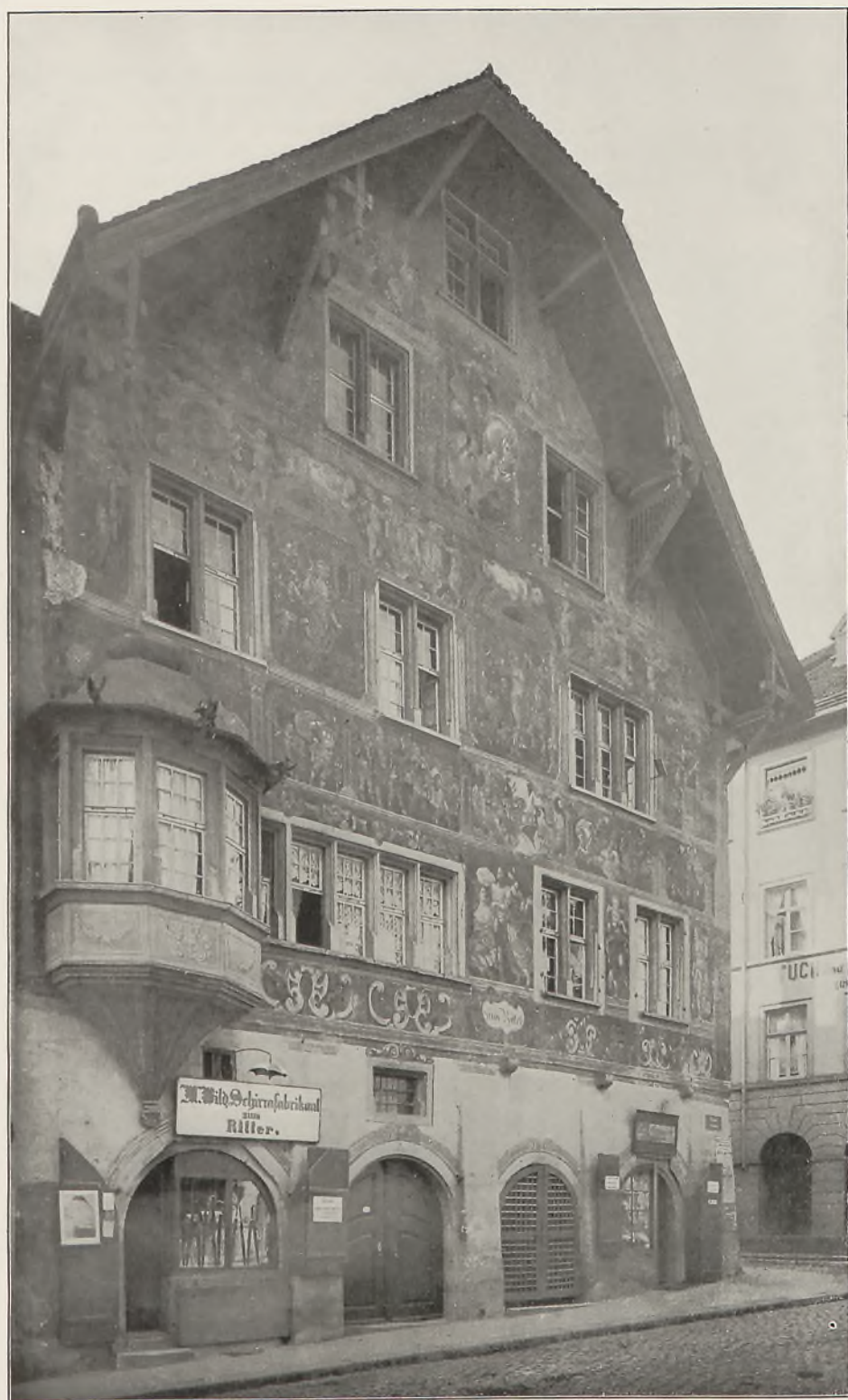
Abb. 177 Fassade des Hauses zum Ritter zu Schaffhausen (Nach Fritsch, Denkmäler deutscher Renaissance)
