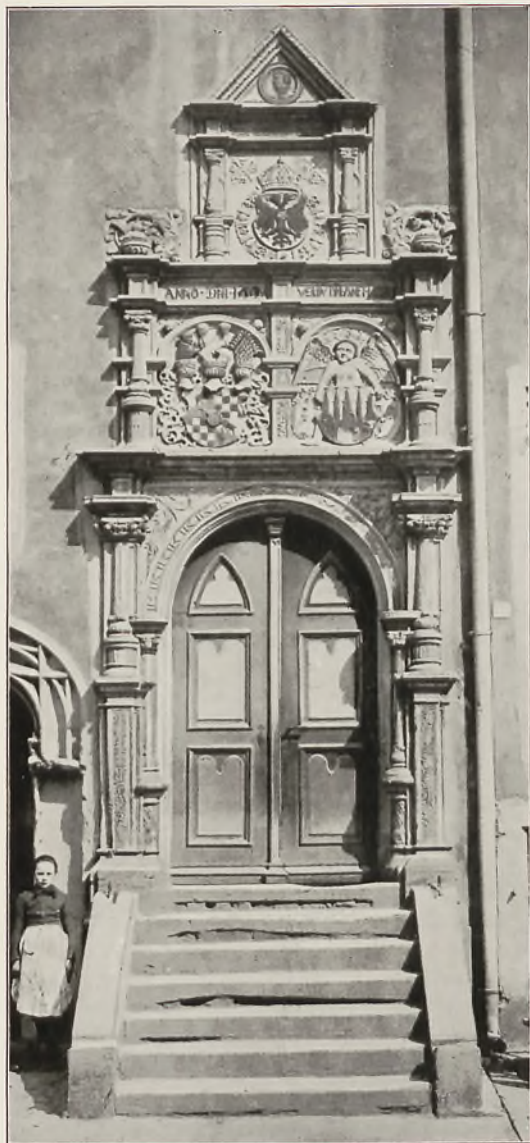
Abb. 116 Eingang der ehemaligen Bürgerschule zu Zerbst (Nach Fritsch, Denkmäler deutscher Renaissance)
