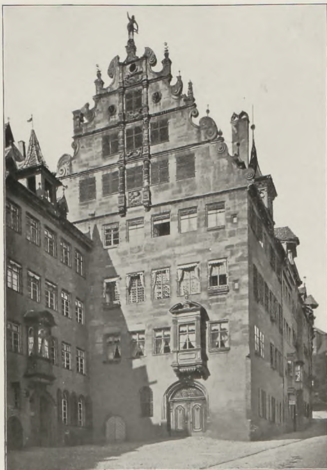
Abb. 320 Fembnhaus zu Nürnberg (Nach Fritsch, Denkmäler deutscher Renaissance)
