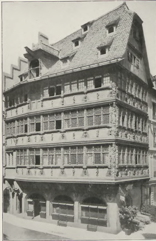
Abb. 191 Haus Kammerzell zu Straßburg (Aufnahme der Neuen Photogr. Gesellschaft, Steglitz)
