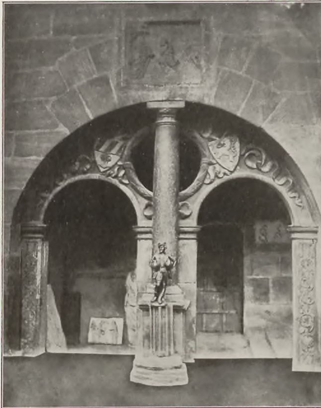
Abb. 309 Portal des Tucherhauses zu Nürnberg
