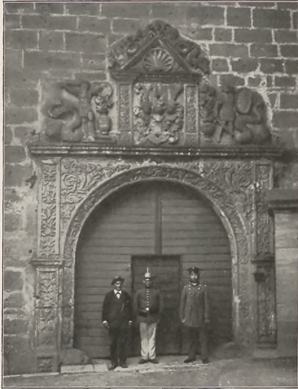
Abb. 326 Hofeingang der Plassenburg
