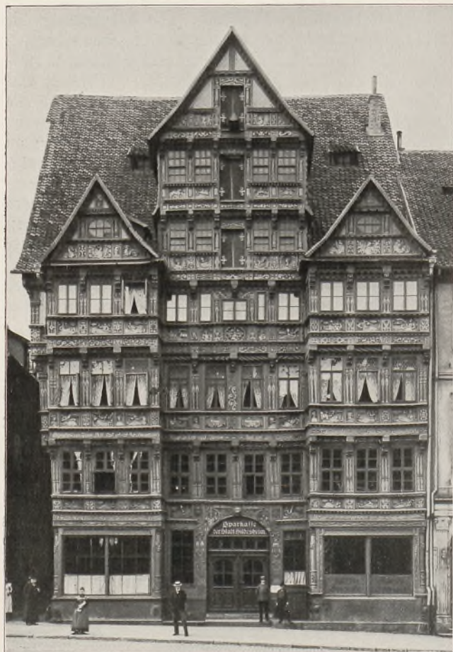
Abb. 287 Wedekindsches Haus zu Hildesheim (Aufnahme der Neuen Photogr. Gesellschaft, Steglitz)
