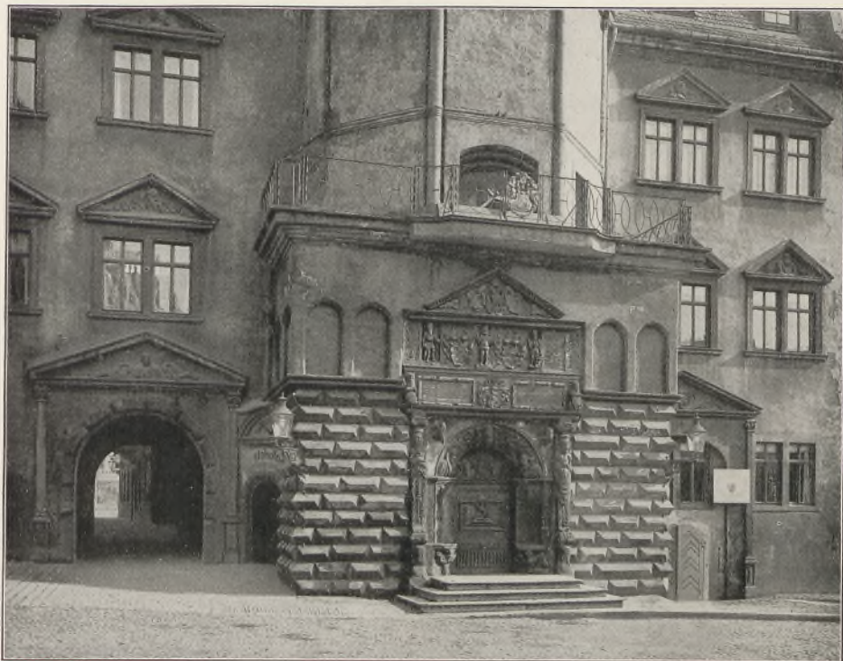
Abb. 255 Haupteingang des Rathauses zu Gera
