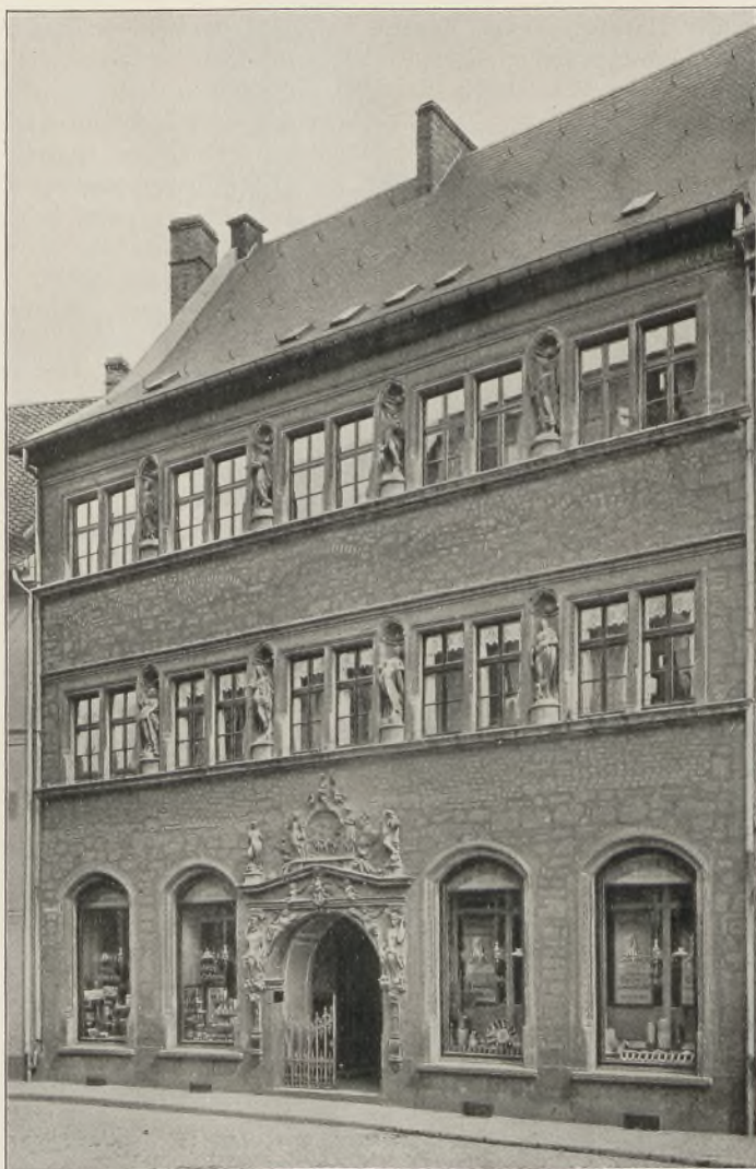
Abb. 283 Altes Gymnasium zu Braunschweig (Aufnahme der Kgl. Meßbildanstalt, Berlin)
