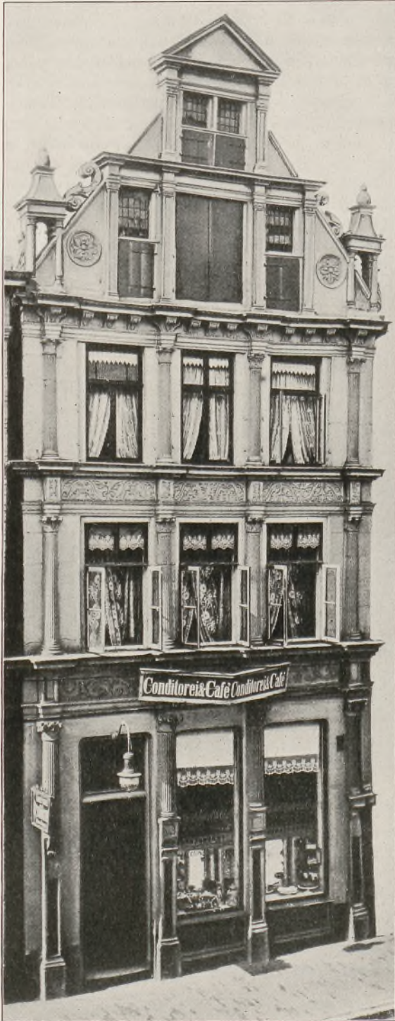
Abb. 201 Haus am Alten Markt zu Emden
