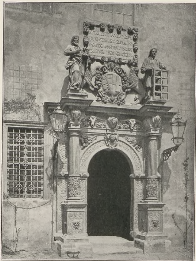
Abb. 249 Portal der Schloßkirche zu Merseburg (Nach: Fritsch, Denkmäler deutscher Renaissance)
