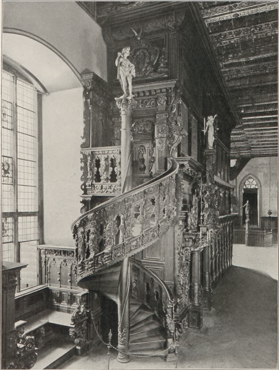
Abb. 196 Wendeltreppe über der Peinkammer im Rathaus zu Bremen (Aufnahme der Kgl. Meßbildanstalt, Berlin)
