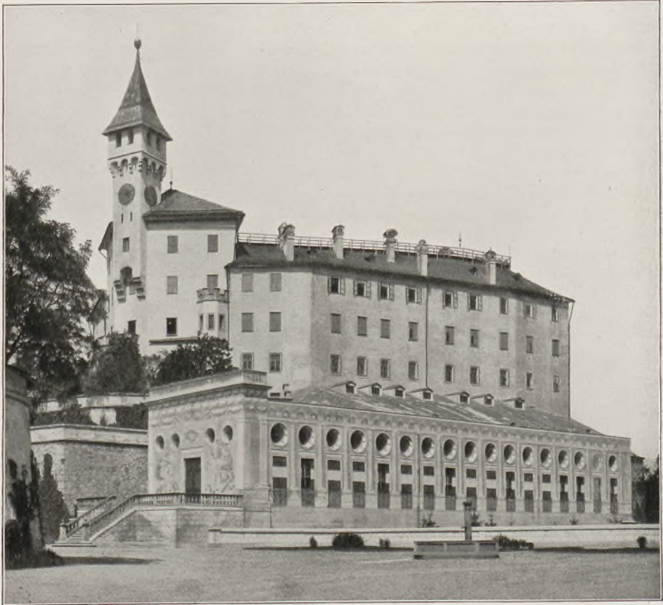
Abb. 51 Schloß Ambras Äußeres mit spanischem Saal
