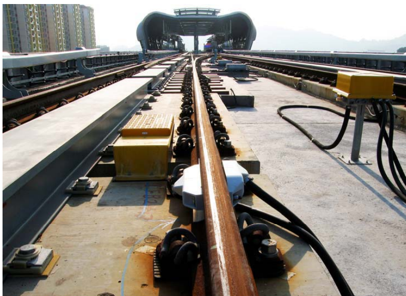
Rys. 3.26. Fragment toru kolejki miejskiej napędzanej silnikami liniowymi (źródło: materiały SIEMENS)
