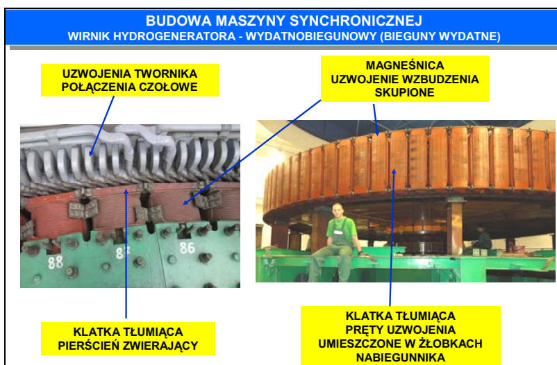
Rys. 6.9. Wirnik hydrogeneratora – Elektrownia Wodna we Włocławku (fot. Mikołaj Kiełczyński)
