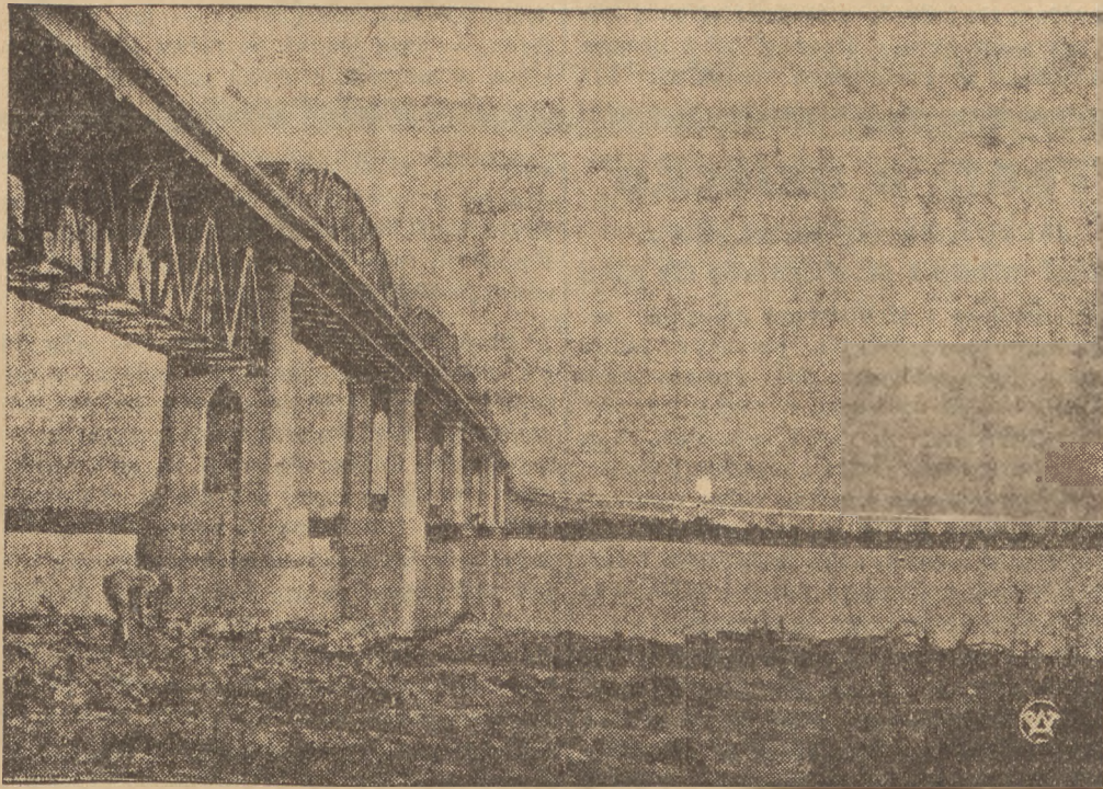
W ub. miesiącu otwarty został most kolejowy na Mississippii, koło Nowego Orleanu. Jest to największy most kolejowy na świecie. Posiada 7 i pół km. długości i 45 m. wysokości. Zbudowany został kosztem 13 milionów dolarów.
