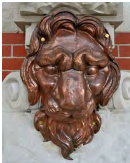
Rekonstrukcja detalu elewacji frontowej Gmachu Głównego zrealizowana z inicjatywy doc. Marianny Sankiewicz Fot. K. Krzempek
