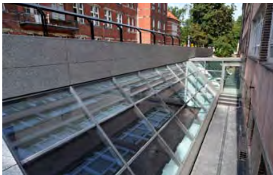
Laboratorium Spektroskopii Elektronowej i fosa wzdłuż budynku „Chemia C” wraz z przeszklonym korytarzem – wejściem do kompleksu podziemnego
