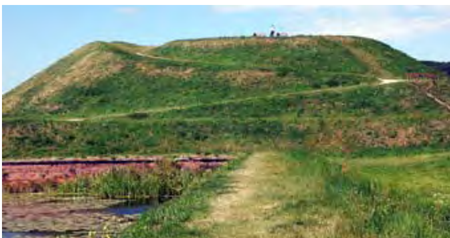
Bastion św. Gertrudy – opływ Motławy
