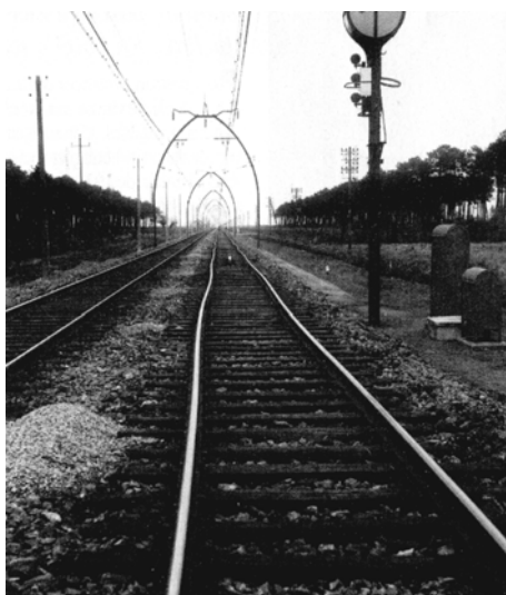
Fot. 2.31. Deformacja nawierzchni po próbie prędkości [10]
