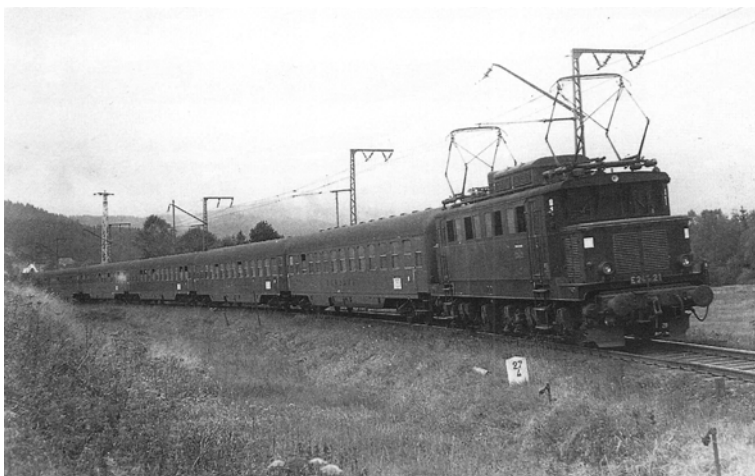
Fot. 2.28. Eksperymentalna lokomotywa zasilana napięciem 20 kV 50 Hz – 1920 [8]
