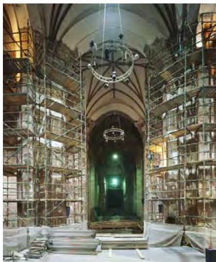
Kościół św. Jana w Gdańsku w trakcie prac konserwatorskich przy malowidłach ściennych, 2006 r.
