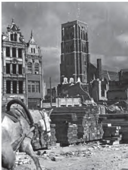
Kościół NMP w Gdańsku w trakcie odbudowy, koniec lat 40. XX wieku
