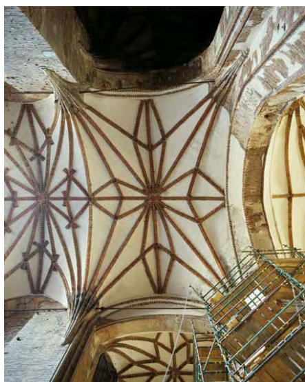
Zrekonstruowane sklepienia kościoła św. Jana w Gdańsku, 2006 r.
