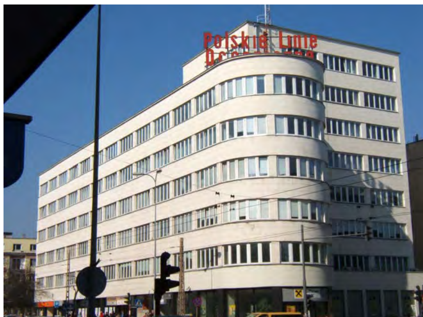
Budynek biurowy ZUS (później PLO), proj. Roman Piotrowski, 1935–36
