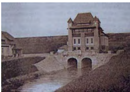
Elektrownia Straszyn – Straschin (źródło: Die Radaune Talsperre mit dem Uberland Kraftwerk Straschin-Prangschin )
