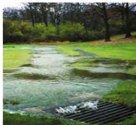
Rys. 13. Hydrofitowa oczyszczalnia wód opadowych; oczyszczone wody przed odprowadzeniem do kanalizacji
