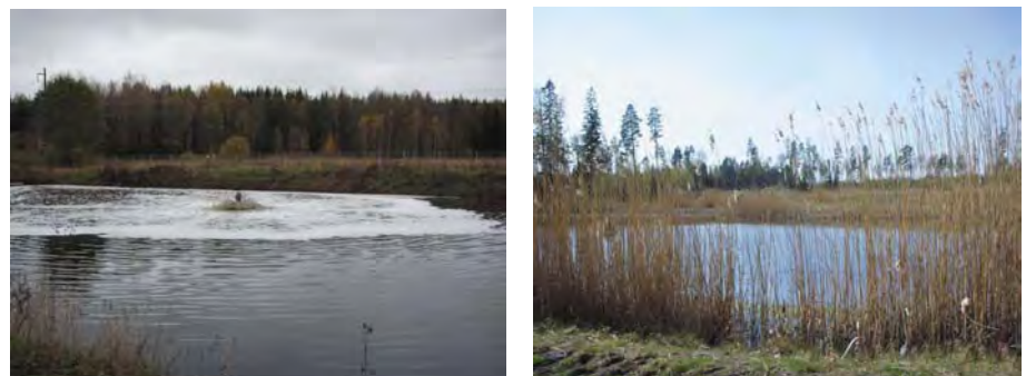
Rys. 12. Hydrofitowa oczyszczalnia odcieków w Örebro: a) pierwszy z szeregu stawów, widok na grzybek napowietrzający, b) widok na jeden ze stawów
