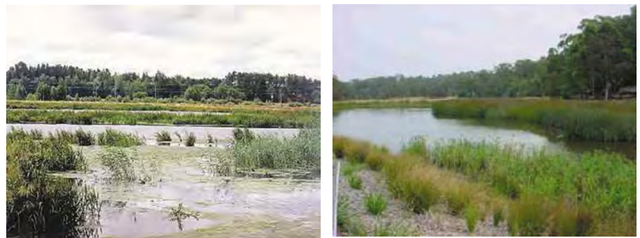
Rys. 11. a) Doczyszczanie ścieków, Ekilstuna, Szwecja, b) ochrona rzeki przed splotem substancji biogennych
