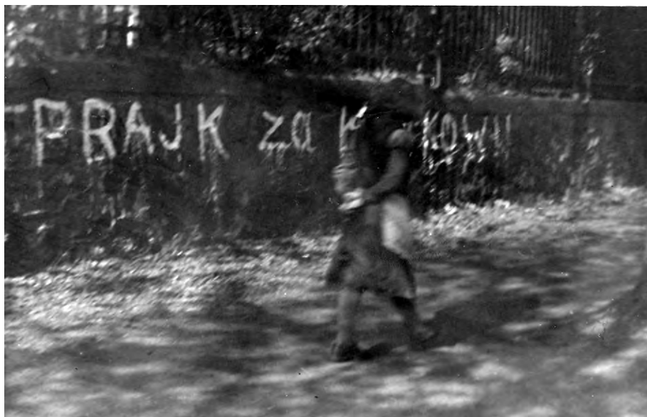
Napis na murze ogrodzenia Politechniki Gdańskiej w maju 1946 roku
