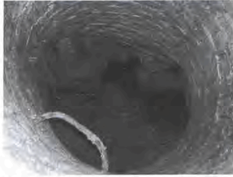
Studzienka kanalizacyjna w obrębie kamiennego kanału wylotowego Fot. F. Borejko
