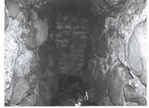
Wylotowy kanał kamienny Fot. F. Borejko
