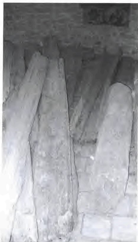
Fragmenty koryt drenażowych, rur wodociągowych, znajdujące się na zamku w Reszlu Fot. F. Borejko
