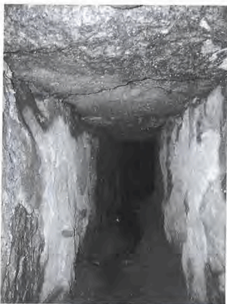
Wylotowy kanał kamienny Fot. F. Borejko
