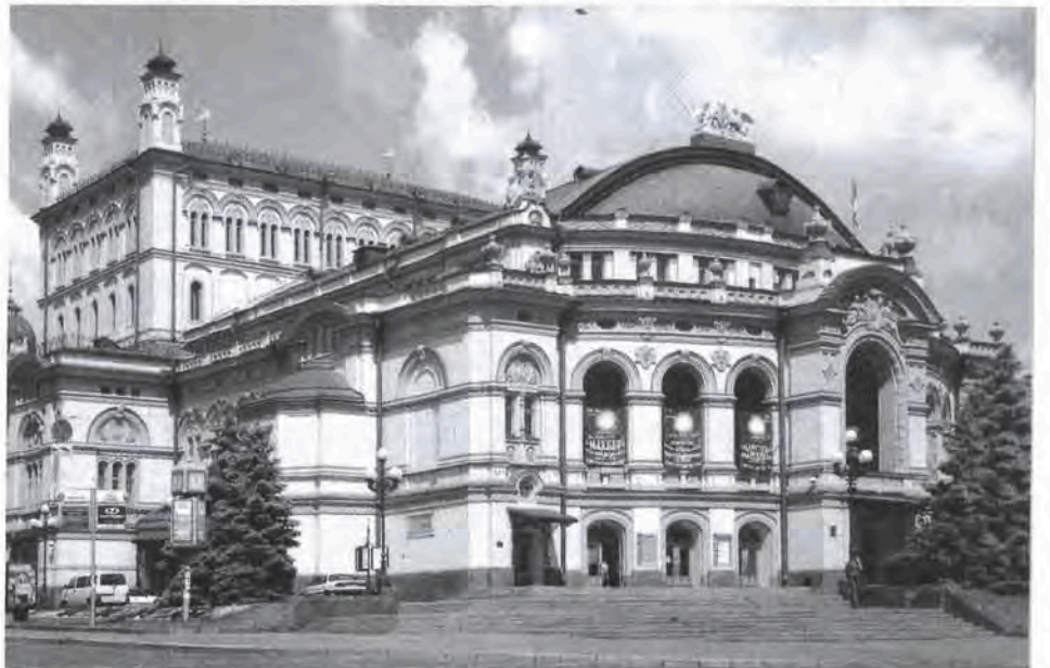
Rys. 6. Budynek kijowskiej opery; wg „Mistectwo” 2008
