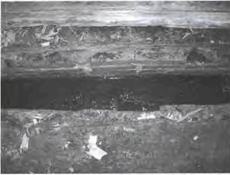
Fragment drenażu obecnie Fot. F. Borejko
